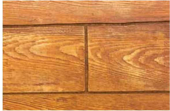
Nicht auf den Fassadenteilen mit der direkten Sonneneinstrahlung anwenden. Die verputzte Fläche sollte vor der direkten Sonneneinstrahlung vor und ca. 24 Stunden nach der Applikation geschützt werden. Man soll die Schutznetze für Gerüst verwenden. Die verputzte Fläche muss sowohl während der Arbeiten sowie in der Trocknungsphase vor direkter Sonneneinstrahlung, Staub, Windeinwirkungen und Niederschlägen geschützt werden.
