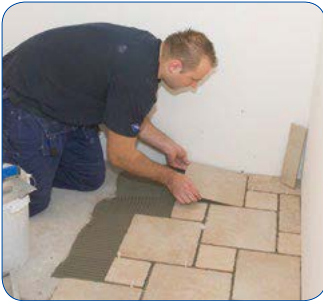
Fot. 1. Für das Verlegen von Bodenfliesen empfiehlt sich das kombinierte Verfahren.
