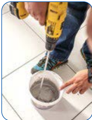
Fot. 2. Zementmörtel werden für den Gebrauch vorbereitet, indem man sie in dem auf der Verpackung angegebenen Verhältnis mit Wasser mischt. Eine falsch bemessene Wassermenge kann zur Folge haben, dass der ausgehärtete Mörtel nicht die vorausgesetzten technischen Parameter und Gebrauchseigenschaften, einschließlich der Farbe, erreicht.
