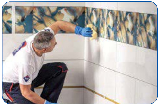
Fot. 3. Für Epoxidfugen müssen Fugen und Fliesen mit einem nassen und gut ausgedrückten Zellstoffschwamm (gelb, von der Rolle geschnitten) abgewaschen und sichtbare Verschmutzungen und matte Stellen auf den Fliesen entfernt werden. Die endgültige Reinigung erfolgt nach dem vollständigen Aushärten des Mörtels – nach etwa 24 Stunden, indem die Fliesen mit warmem Wasser mit Zusatz eines Reinigungsmittels oder von Spiritus abgewaschen werden.
