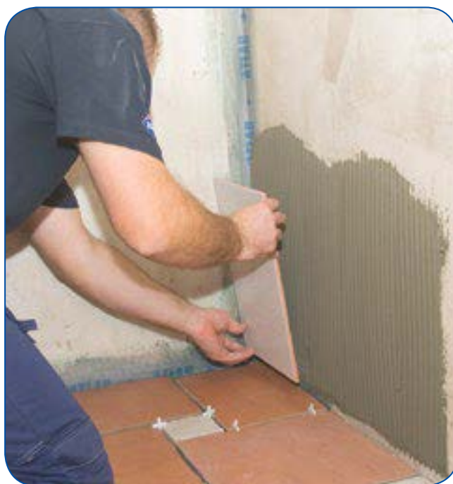
Fot 3. Wenn der Untergrund mit einer Hydroisolierung bedeckt ist, müssen die Anweisungen des Herstellers der hydroisolierenden Schicht beachtet werden. In der Regel spricht nichts gegen die Anwendung eines C1-Klebers, aber im Hinblick auf die Nutzungsfaktoren wählt man besser einen C2-Kleber.
