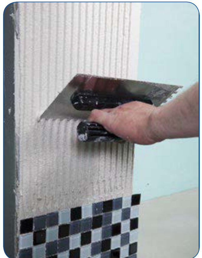
Fot. 2. Beim Verlegen von Mosaik besteht bei einer zu dicken Schicht Kleber die Gefahr, dass die Mosaiksteine versinken, dass Mörtel aus den Fugen tritt und ein welliger Effekt entsteht, so dass die Fläche keine perfekte Ebene bildet.
