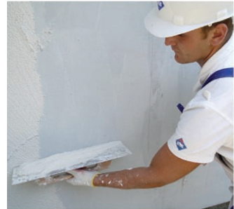
Auftragen des Verputzes mit einem Stahlreibebrett
