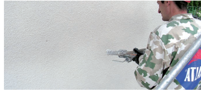
Auftragen des Verputzes mittels Beschichtung
