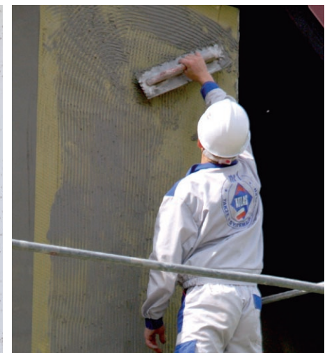
DAS EINKLEBEN DES NETZES
