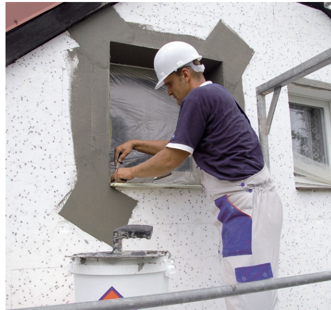
BEARBEITUNG EINER FENSTERÖFFNUNG UNTER EINSATZ VON ECKKANTEN UND NETZEN IM DIAGONALEN SYSTEM
