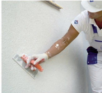
Auftragen des Verputzes mit einem Stahlreibebrett
