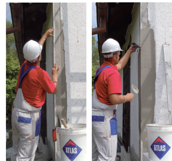
MONTAGE DER ECKKANTEN
