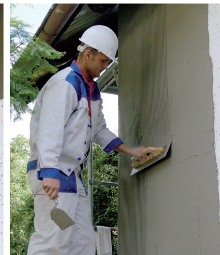
DAS PROFILIEREN DES KLEBSTOFFES MIT EINEM ZAHNREIBEBRETT
