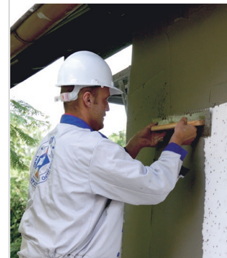
DAS AUFTRAGEN DES KLEBSTOFFES AUF DAS STYROPOR
