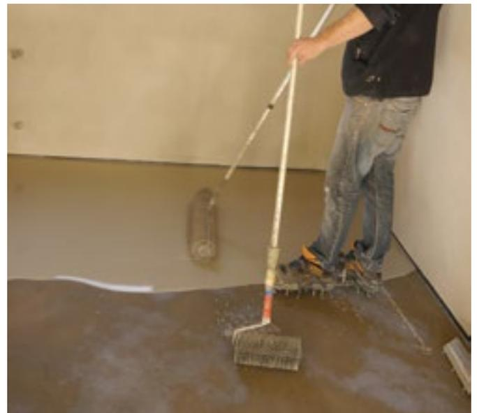
Foto 4. Vereinheitlichung und Entlüftung des Mörtels mit einer Gitterwalze.
