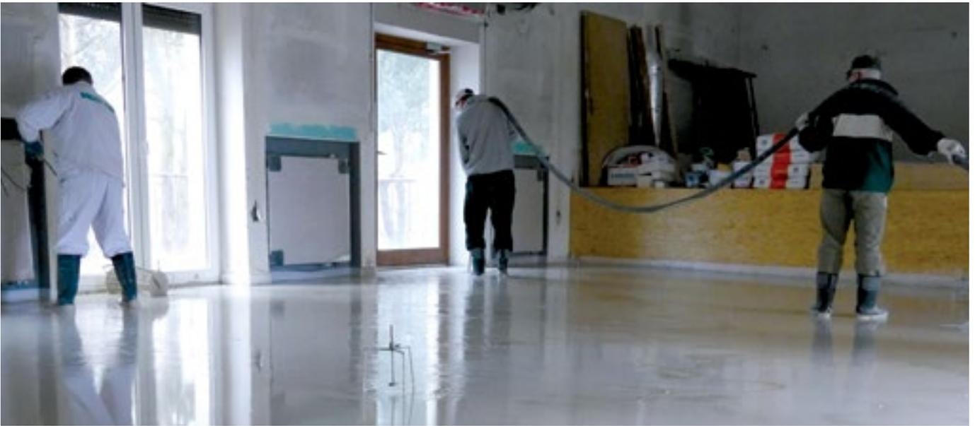
**Foto 2. Die maschinelle Anwendung von schnellbindenden Anhydritestrichen bewährt sich vor allem auf großen Flächen (über 15 m<sup>2</sup>).**
