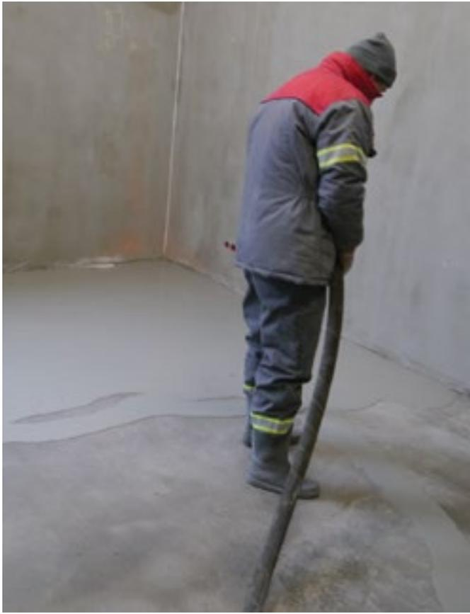
**Foto 5. Die selbstnivellierenden Massen ATLAS SMS 15 und SMS 30 können maschinell auf großen Flächen aufgetragen werden.**
