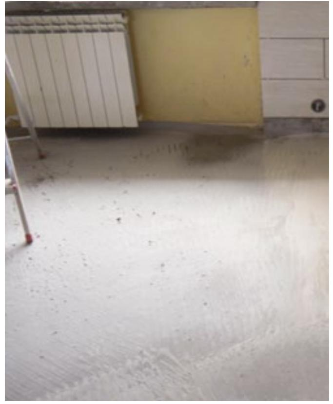
**Foto 8. Die Anwendung von zu wenig Wasser hat zu Schwierigkeiten beim Glätten der Spachtelschicht geführt.**
