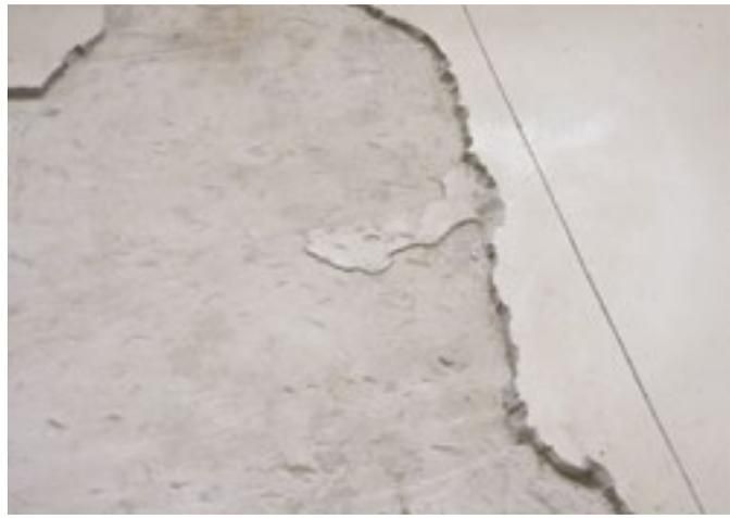
Foto 3. Risse und Ablösungen einer zu dünnen Estrichschicht.
