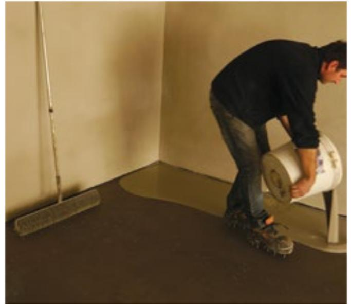
Foto 3. Der Mörtel sollte in gleichmäßigen Schichten, beginnend an der vom Eingang am weitesten entfernten Wand gegossen werden.
