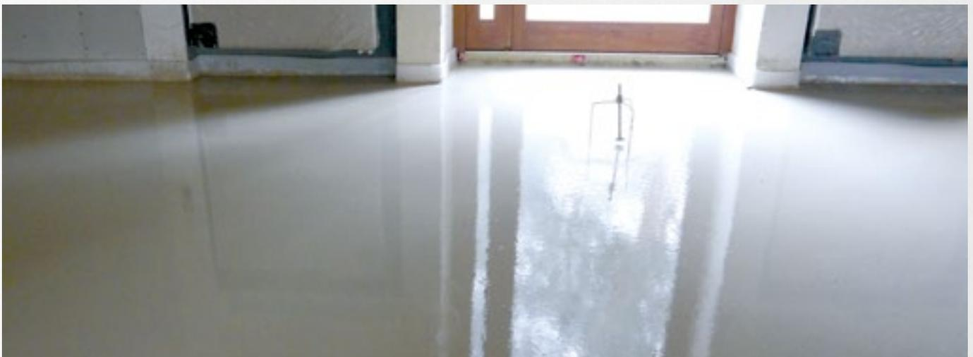
Foto 1. Maschinelles Auftragen von selbstnivellierendem Estrich auf einem alten Betonuntergrund.
