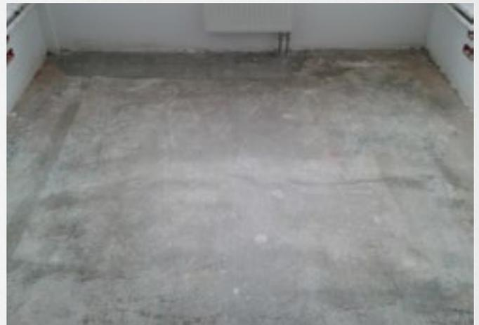
**Foto 1. Grundierung mit der Emulsion ATLAS Uni-Grunt.**
