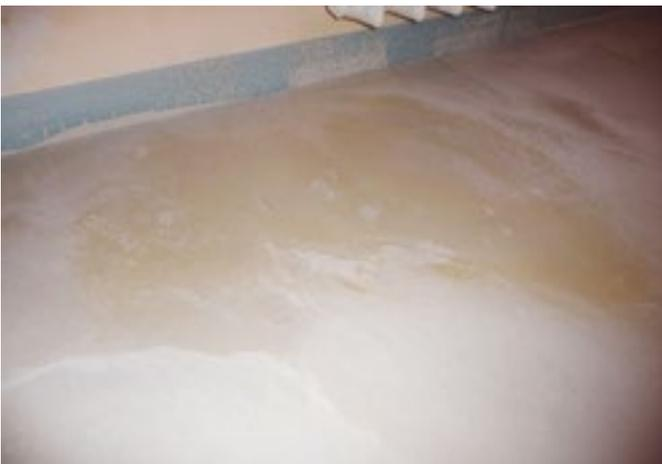
**Foto 7. Beispiel für die Anwendung von zu viel Betriebswasser, der Anhydritestrich hat eine unregelmäßige Färbung infolge des Auswaschens der chemischen Zusätze.**
