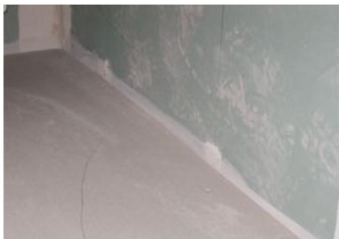
Foto 5. Schwundrisse im Estrich. Sichtbares Fehlen einer Randfuge entlang der Wände.
