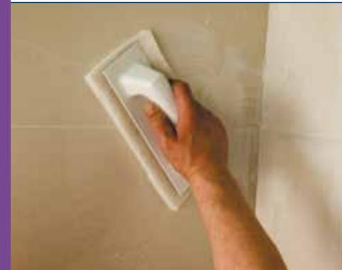
Epoxid-Fugen, beispielsweise ATLAS ARTIS bestehen aus zwei Komponenten: die Masse (A) und der Härter (B) und werden im Satz geliefert. Diese sollen genau, unter der Einhaltung der Hinweise auf der Verpackung vermischt werden. Die Masse soll sorgfältig und tief in die Spalten, mit einem Gummibrett eingeführt werden. Die Resten der Masse sind von der Oberfläche umgehend (nicht später als nach 20 Minuten) mit einem harten, nassen Schwamm (kaltes Wasser) zu entfernen.
