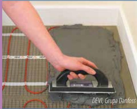
Bei der Montage von Heizungsmatte wird diese im frisch aufgetragenen verformbaren Kleber, während der Ausführung eines Fliesenbelags eingetaucht. Hierfür soll einer der Mörtel der Linie ATLAS PLUS, am besten des PLUS MEGA für größere Schichtstärken eingesetzt werden. Wenn der Belag aus Steinfliesen hergestellt werden sollte, so wird der Einsatz von PLUS MEGA bzw. PLUS MEGA WEISS empfohlen.
