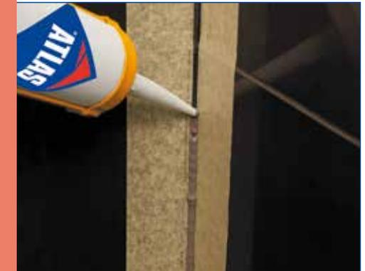
Das Silikon gleichmäßig in die Spalten so einführen, damit eine unwesentliche Menge Restmaterial bleibt. Keine freien Stellen lassen. Während 10-15 Minuten die Oberfläche des Silikons mit einer speziellen Kelle glätten. Die Kelle zuvor in einer Wasserlösung, beispielsweise mit Seife nass machen. Es wird empfohlen, die Fugen so zu gestalten, damit das Wasser frei abfließen kann. Wir empfehlen das Sanitär-Silikon ATLAS ARTIS, das gegen Pilz und Schimmel resistent ist.
