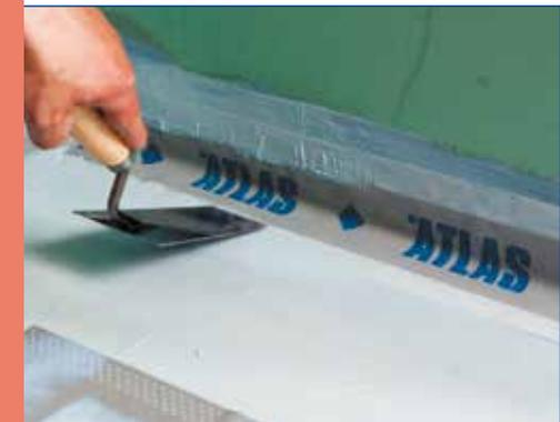
Die Kanten, welche die Wand mit dem Fußboden bzw. mit der benachbarten Wand verbinden, aber auch den eventuellen Dilatationen entlang sind die ABDICHTUNGSBÄNDER ATLAS einzukleben. Hierfür ist diesen Kanten entlang die Hydroisoliermasse so anzubringen, damit man darin die Netze, die sich auf beiden Seiten dieses Bandes befinden einlassen kann. Ähnlich sind die DICHTUNGSECKEN ATLAS, welche die Bänder in den Eckbereichen der Räume ergänzen zu befestigen.
