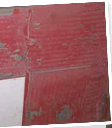
→ Źle przygotowana płyta OSB – niezeszlifowana; brak podkładu typu Cerplast.
