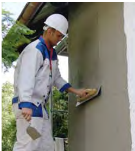
PROFILOWANIE KLEJU PACĄ ZĘBATĄ
