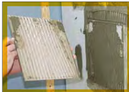
FOT.5 Przyklepanie płytki klejem Ceresit CM16
