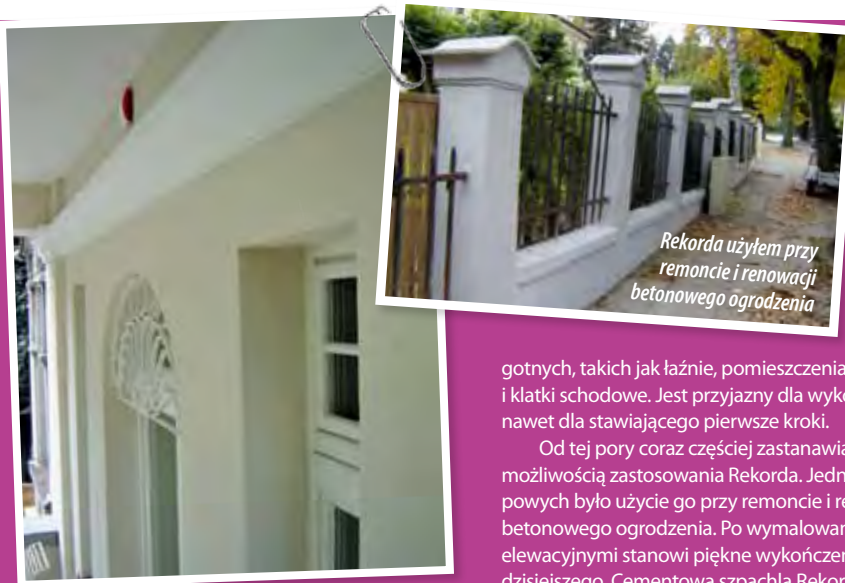
Elewacja zewnętrzna willi – Rekord dobrze nadawał się jako materiał wypełniający niewielkie ubytki oraz do wygładzenia powierzchni zewnętrznych ścian i murów
