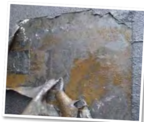
FOT. 4. Za wcześniej nakładana powłoka główna – bez całkowitego wyschnięcia gruntu.
