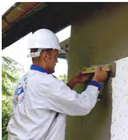
NAKŁADANIE KLEJU NA STYROPIAN
