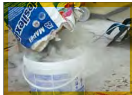
FOT.3 Pylenie kleju Mapei Adesilex P9
