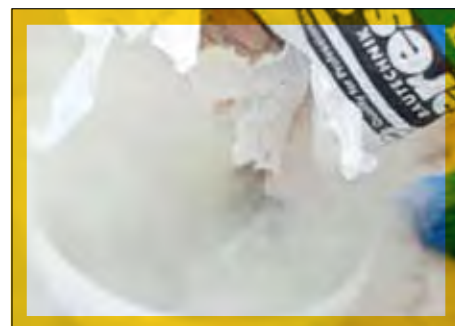
FOT.2 Pylenie kleju Ceresit CM16
