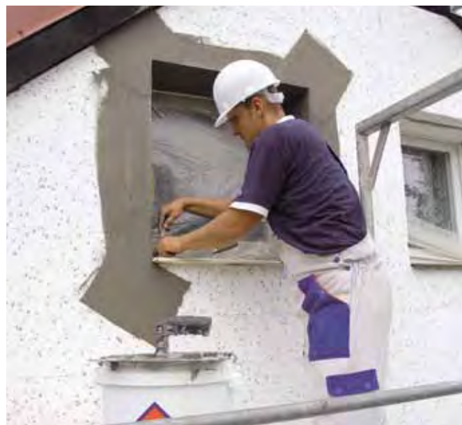
OBRÓBKA OTWORU OKIENNEGO Z ZASTOSOWANIEM NAROŻNIKÓW I SIATKI W UKŁADZIE DIAGONALNYM
