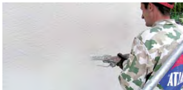
Nakładanie tynku metodą natryskową
