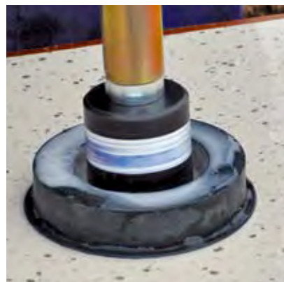
FOT. 5 Wiercenie techniką na mokro (np. Montolit FA)
