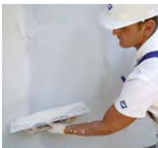
Nakładanie tynku pacą stalową
