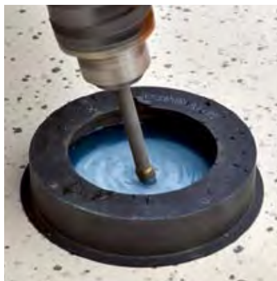
FOT. 4 Wiercenie techniką na mokro (np. Montolit „MU”)
