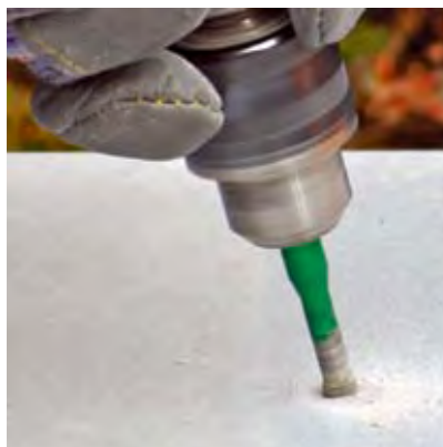
FOT. 1 Wiercenie techniką na sucho (np. Montolit FTJ)
