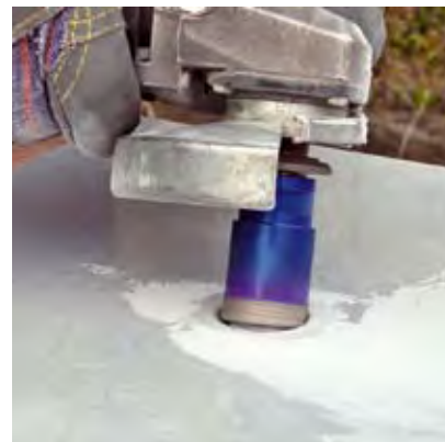
FOT. 2 Wiercenie techniką na sucho (np. Montolit FS)
