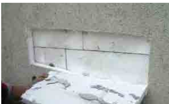
FOT. 4 W skrajnych przypadkach stosowano klejenie płyt styropianowych warstwowo bez łączników mechanicznych z użyciem tylko kleju cementowego.
