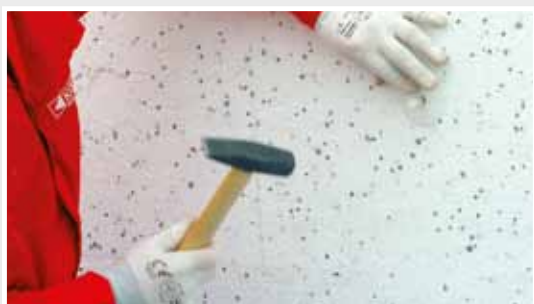
3 Wbicie młotkiem trzpienia rozporowego do momentu gdy główka łącznika znajdzie się w płaszczyźnie elewacji.
