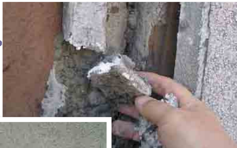
FOT. 3 Do niwelowania dużych uskoków płaszczyzny ścian używano podkładek z pasków styropianu.
