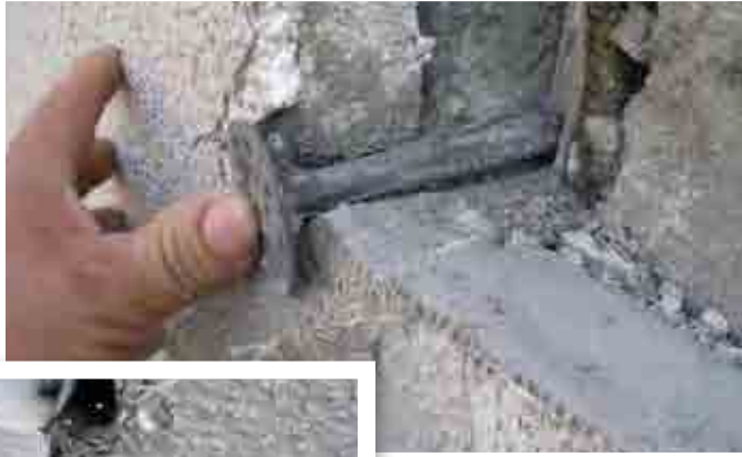
FOT. 10 W niektórych miejscach kołki samoistnie wypadły z lica elewacji.
