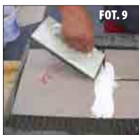
FOT. 8, 9 Fugowanie białą fugą Atlas Artis zaraz po przyklejeniu płytek
