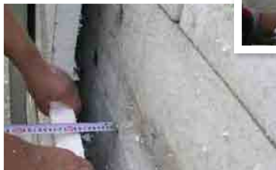
FOT. 5 Brak łącznika doprowadził między innymi do całkowitego odspojenia się (na powierzchni kilkudziesięciu metrów kwadratowych) warstwy wierzchniej płyt styropianowych i zawieszenia jej na siatce zbrojącej i wyprawie tynkarskiej.
