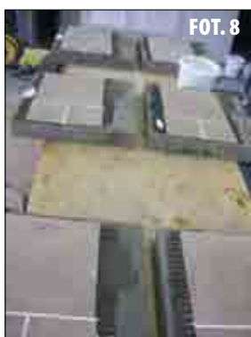
FOT. 8, 9 Fugowanie białą fugą Atlas Artis zaraz po przyklejeniu płytek
