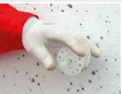
Wprowadzenie łącznika do otworu.
