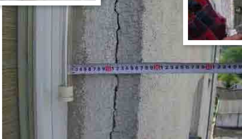
FOT. 5 Brak łącznika doprowadził między innymi do całkowitego odspojenia się (na powierzchni kilkudziesięciu metrów kwadratowych) warstwy wierzchniej płyt styropianowych i zawieszenia jej na siatce zbrojącej i wyprawie tynkarskiej.
