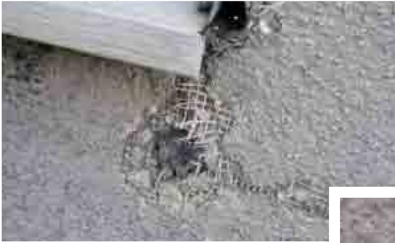
FOT. 8 Brak zbrojenia diagonalnego w płaszczyźnie ściany przy narożach otworów skutkowało powstaniem pęknięć i ubytków.
