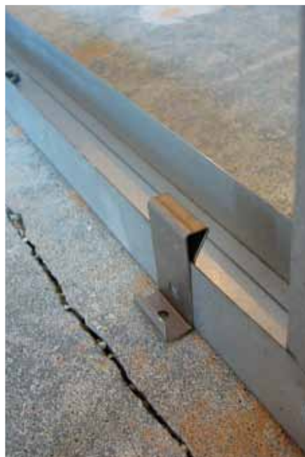
FOT. 2 Łącznik łączy płyty po obu stronach ścianki z profilem pionowym oraz pomiędzy sobą.
