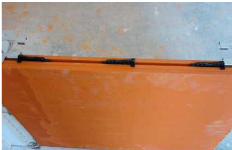
FOT. 4. Zamki spełniają rolę elementów dystansowych pomiędzy kolejnymi rzędami płyt oraz stabilizują połączenie sąsiadujących ze sobą płyt.
