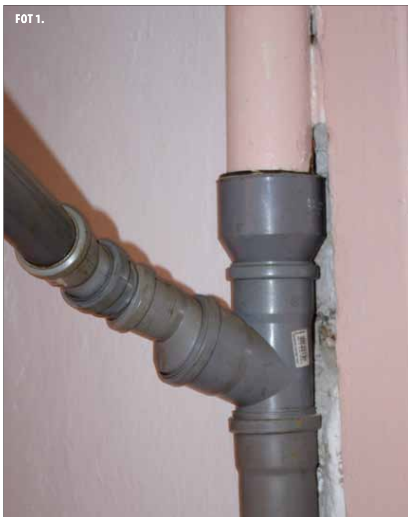
FOT 1. Przykład połączenia starej i nowej kanalizacji
