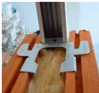
FOT. 2 Łącznik łączy płyty po obu stronach ścianki z profilem pionowym oraz pomiędzy sobą.
