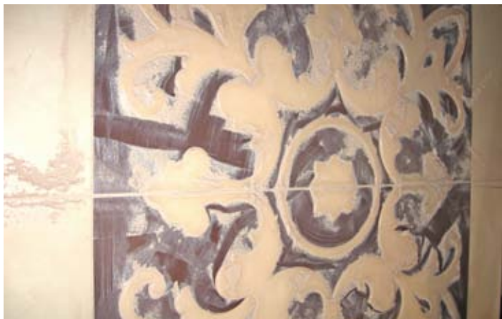
Fot. 2. Fugę epoksydową kładziemy wtedy, gdy mamy możliwość dnia następnego (np. kończymy pracę ok. 17, a następnego dnia zaczynamy wcześniej rano) dopieścić detale i ewentualnie usunąć pozostały nalot i nadmiar, który czasem pozostaje w dekorach i innych elementach mających różne zakamarki. Dnia następnego ją również uzupełniam braki oraz zbieram nożykiem nadmiar z narożników wewnętrznych i zewnętrznych.
