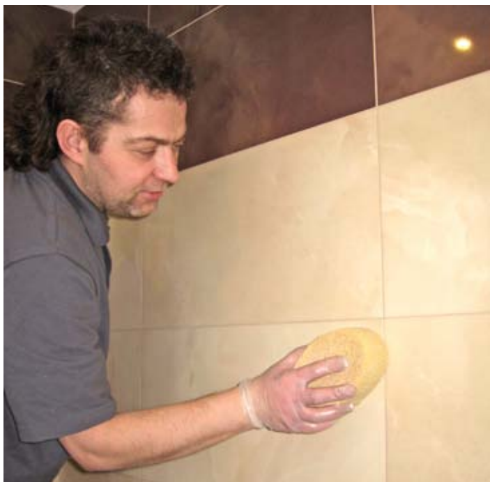
Fot. 3. Powierzchnię okładziny zmywamy gąbką typu Scotch-brite bezpośrednio po spoinowaniu, obficie używając wody.
