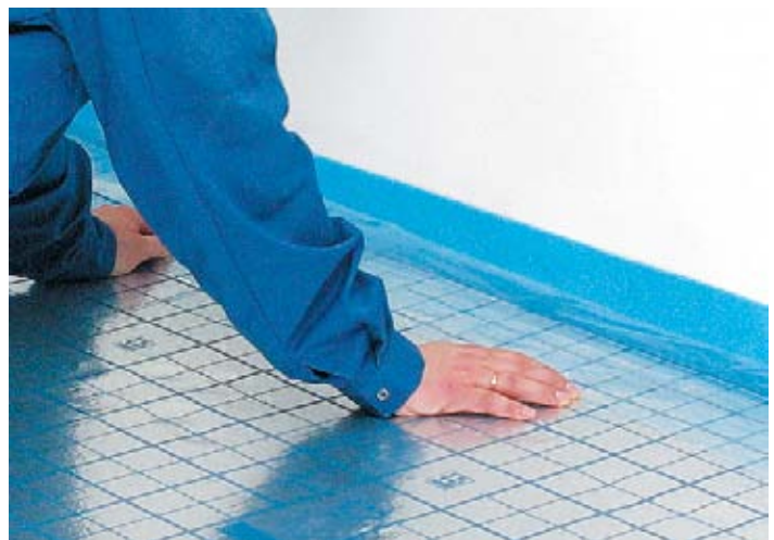
Rys. 3 Układanie izolacji termicznej
