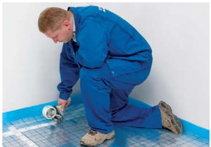
Rys. 4 Klejenie taśm samoprzylepnych
