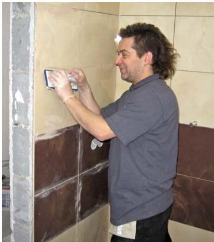
Fot. 1. Fuga epoksydowa Atlas Artis, jak i innych producentów do mokrego się nie klei, więc pośpiech niewskazany. Szczeliny między płytkami muszą być suche!
