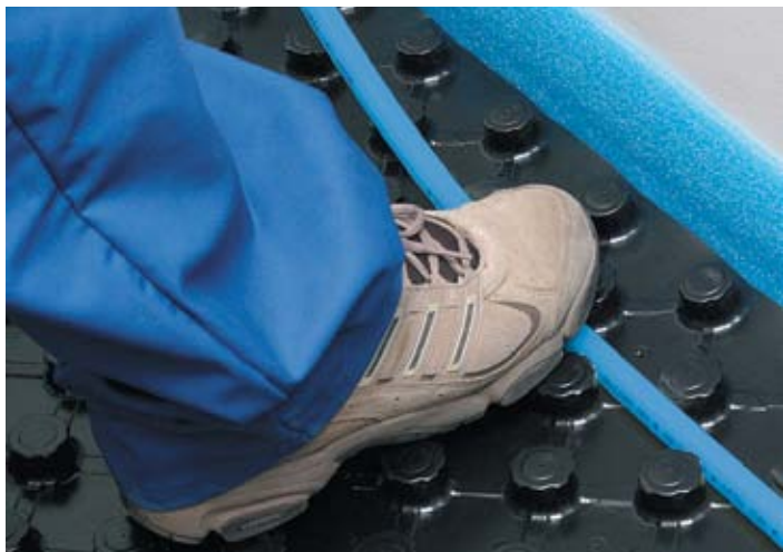
Rys. 7 Mocowanie rury na macie z wypustkami
