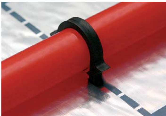
Rys. 6 Zamontowane rury grzewcze
