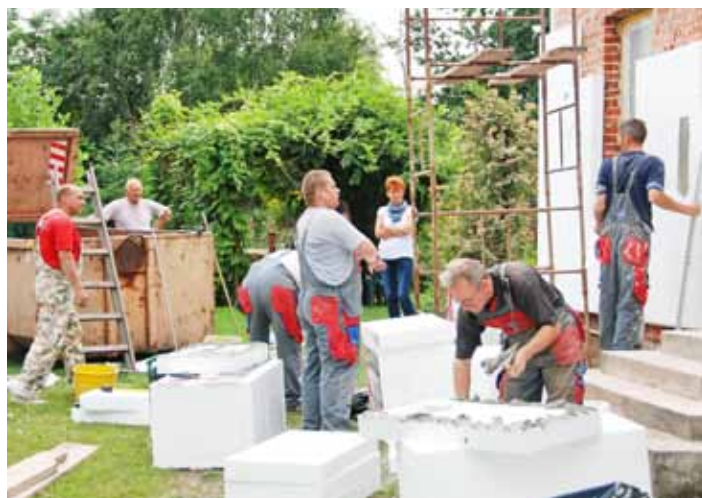
Fot. 2. Współ w zespół – nakładanie zaprawy na styropian i montowanie płyt na ścianie... Wszystko jak w zegarku.
