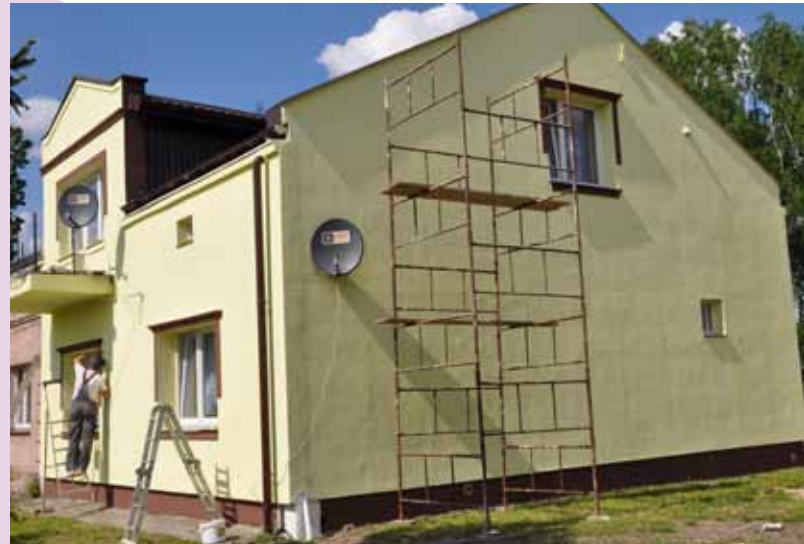
Fot. 7. Dom w prawie ostatecznym kształcie. Pomalowany farbą ATLAS Fastel Nova w dwóch odcieniach.
