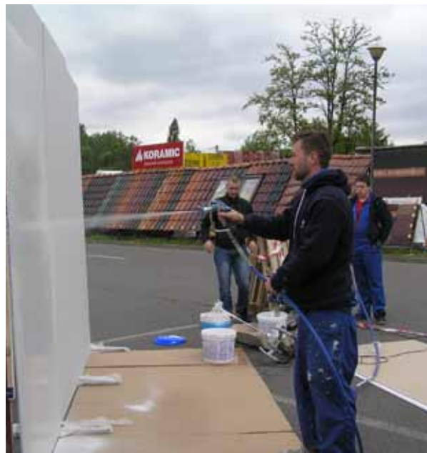
Fot. 2. Pokaz natryskowego nakładania gładzi Rapid maszynami Graco.
