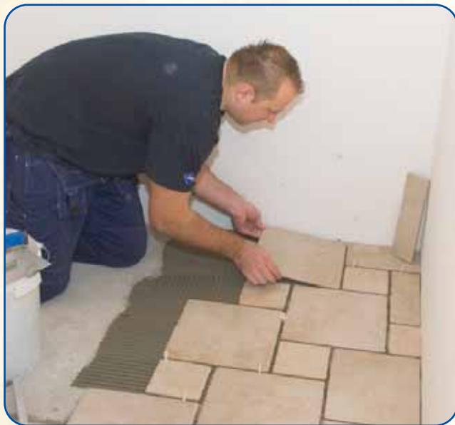
Fot. 1. W przypadku mocowania płytek podłogowych zaleca się metodę kombinowaną.
