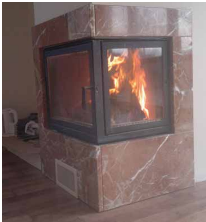
Fot 1. Przykład zlicowania się kominka ze ścianą pomieszczenia
