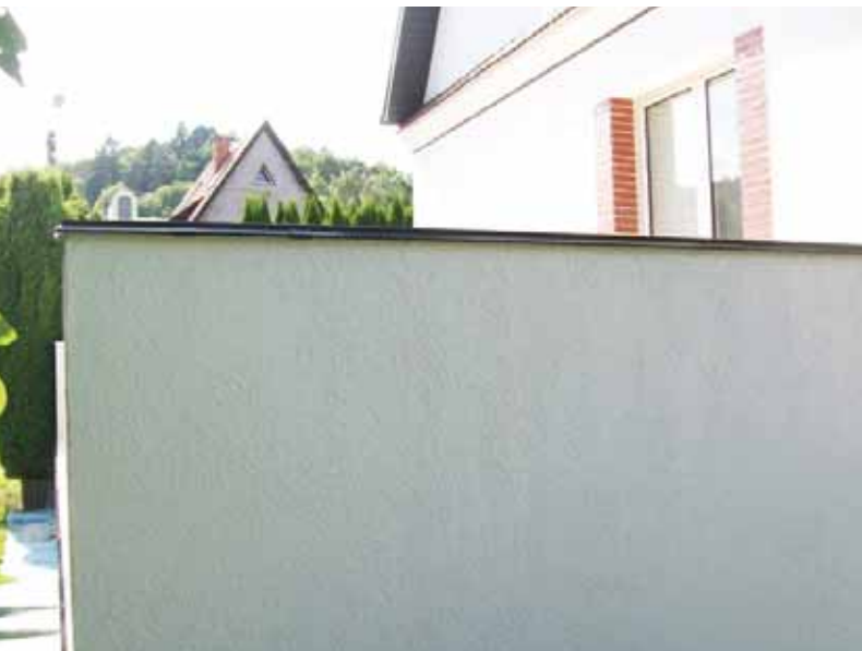
Fot 4. Wykończone murki wykonane z użyciem okapników systemowych
