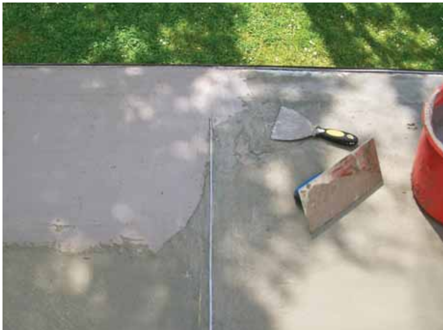
Fot 2. Druga warstwa izolacji i wciśnięcie sznura w dylatację
