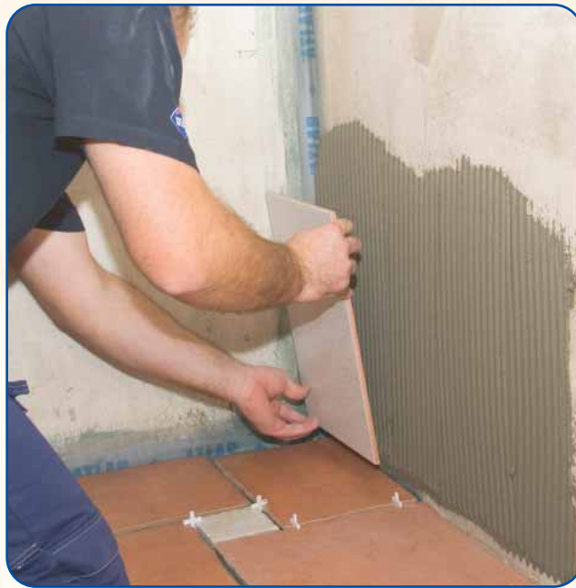
Fot. 4. Gdy podłoże pokryte jest hydroizolacją, powinniśmy przestrzegać zaleceń producenta tej warstwy. Z reguły nie ma przeciwwskazań do stosowania klejów C1, ale ze względu na czynniki eksploatacyjne lepiej wybrać klej C2.
