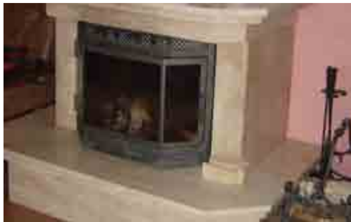
Fot. 3. Typowy przykład kominka marmurowego z żeliwnym wkładem i zamkniętym paleniskiem.
