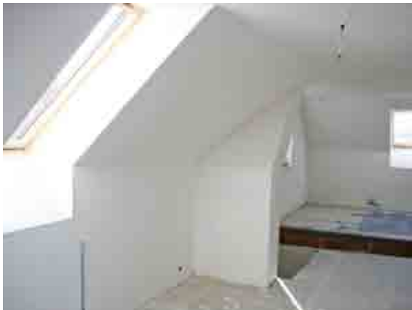
Fot. 2. Na podłożu z płyt g-k postanowiłem nałożyć dwie warstwy gładzi prostopadłe do siebie, z czego pierwszą równoległą do okna.
