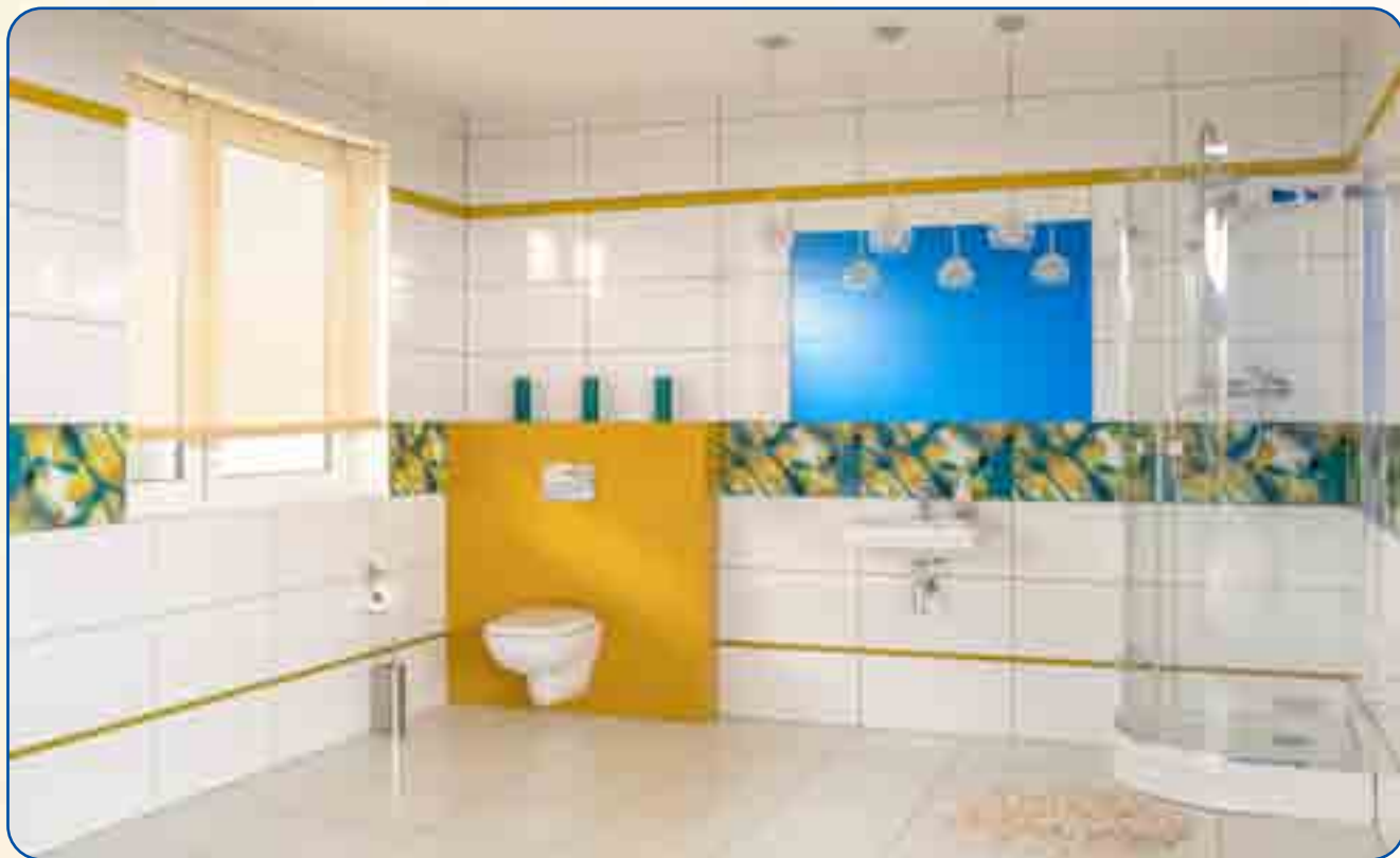
Fot. 1. Dobór spoin ze względu na kolor uzależniony jest od kwestii funkcjonalnych. Na etapie doboru koloru spoiny zalecane jest uwzględnienie miejsca jej wbudowania. Na posadzkach lepiej stosować ciemniejsze odcienie, które w mniejszym stopniu będą się brudzić. Natomiast na ścianach i elementach dekoracyjnych kolor spoin może być jaśniejszy.
