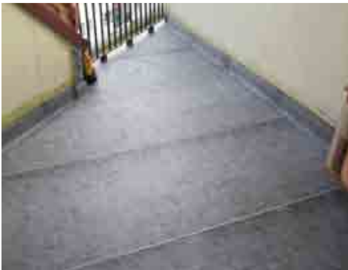
Fot. 5. Przykład zastosowania maty kompensująco-uszczelniającej.
