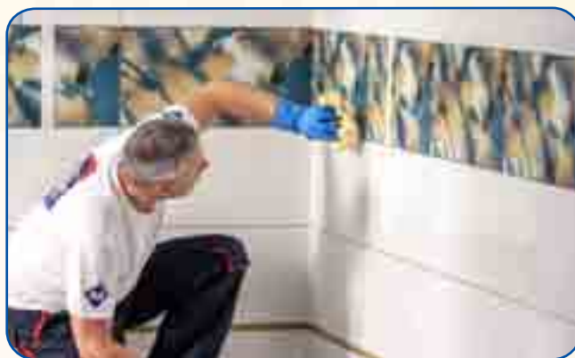
Fot. 3. W przypadku fugi epoksydowej spoiny i płytki należy przemyć gąbką celulozową (żółtą, ciętą z balotu), zmoczoną i dobrze wyciśniętą, usuwając widoczne zabrudzenia lub zmatowienia powstałe na płytkach. Ostateczne czyszczenie przeprowadza się po całkowitym utwardzeniu zaprawy – po około 24 godzinach, przemywając płytki ciepłą wodą z dodatkiem detergentu lub spiritusu.
