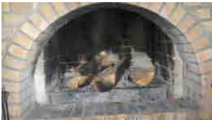
Fot. 1. Tradycyjny kominek ceramiczny, otwarty, z rusztem paleniskowym.
