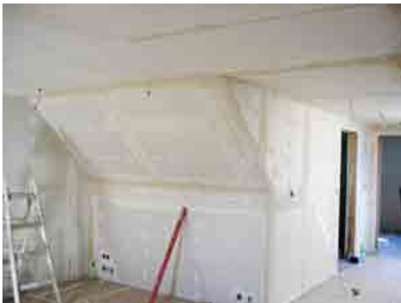
Fot. 1. Płyty g-k były spajane na długości łączących wzdużnych oryginalnych i tych fazowanych z zachowaniem niewielkiej przerwy.
