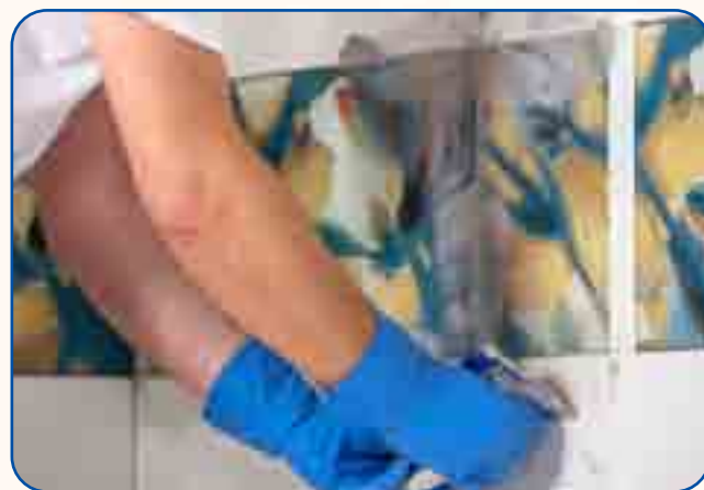
Fot. 4. Pacę do spoinowania należy prowadzić pod kątem około 45°, ukośnie w stosunku do przebiegu spoin – umożliwi to ich dokładniejsze i łatwiejsze wypełnienie. Po wypełnieniu spoin należy odczekać do wstępnego związania zaprawy, objawiającego się jej zmatowieniem w spoinie.
