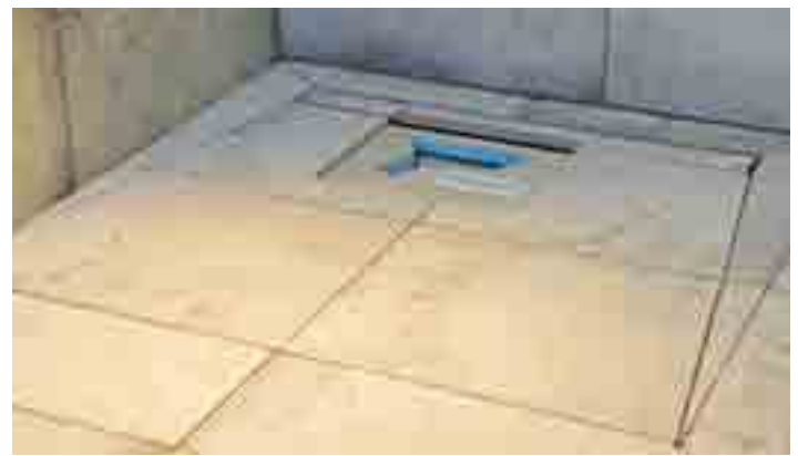
Fot. 3. Wytrzymałość odpływów na nacisk musi być dostosowana do maksymalnej masy, jaka będzie przyłożona do danej jednostki powierzchni. W przeciwnym razie może dojść do zapadnięcia się odpływu, a tym samym uszkodzenia tego przedmiotu, który został położony, lub spowodowania niebezpieczeństwa dla zdrowia użytkownika brodzika.
