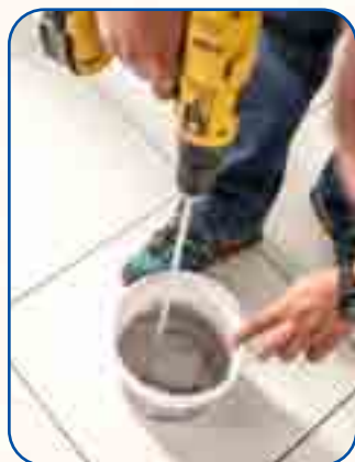
Fot. 2. Zaprawy cementowe przygotowywane przez wymieszanie z wodą w proporcjach podanych na opakowaniu. Niewłaściwa ilość wody może sprawić, że utwardzona zaprawa nie uzyska zakładanych parametrów technicznych i użytkowych, w tym koloru.
