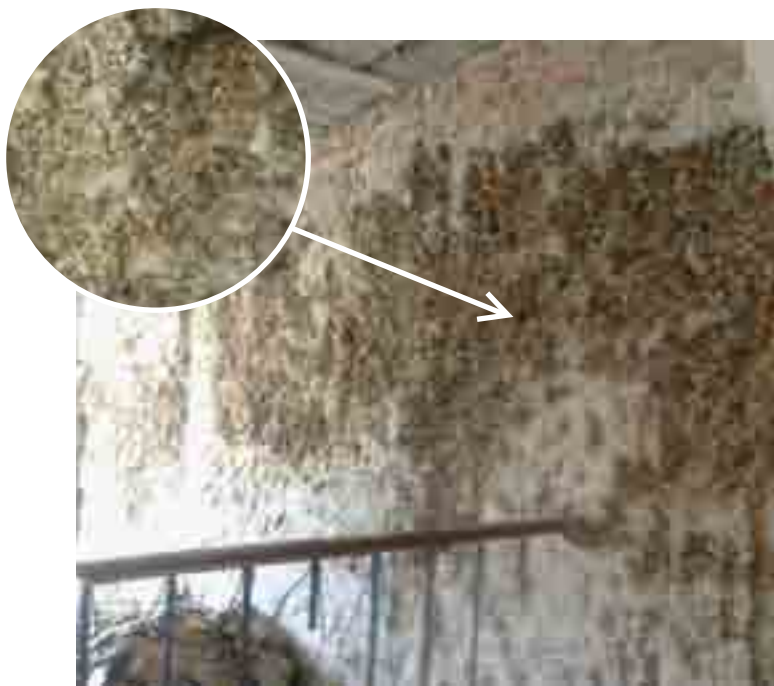
Fot. 4. Co to jest? Zastanawiali się niektórzy po skuciu starego tynku ze ścian. To tłuczeń cegły, przelany betonem, a w zasadzie wodą cementową. Tłuczeń z „monolitu” można było wyjmować ręką...
