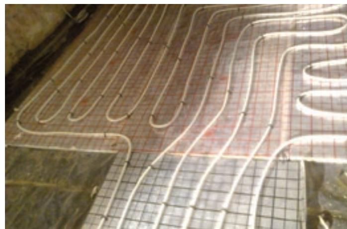
Fot. 2. Ogrzewanie podłogowe, folia PE 0,2.
