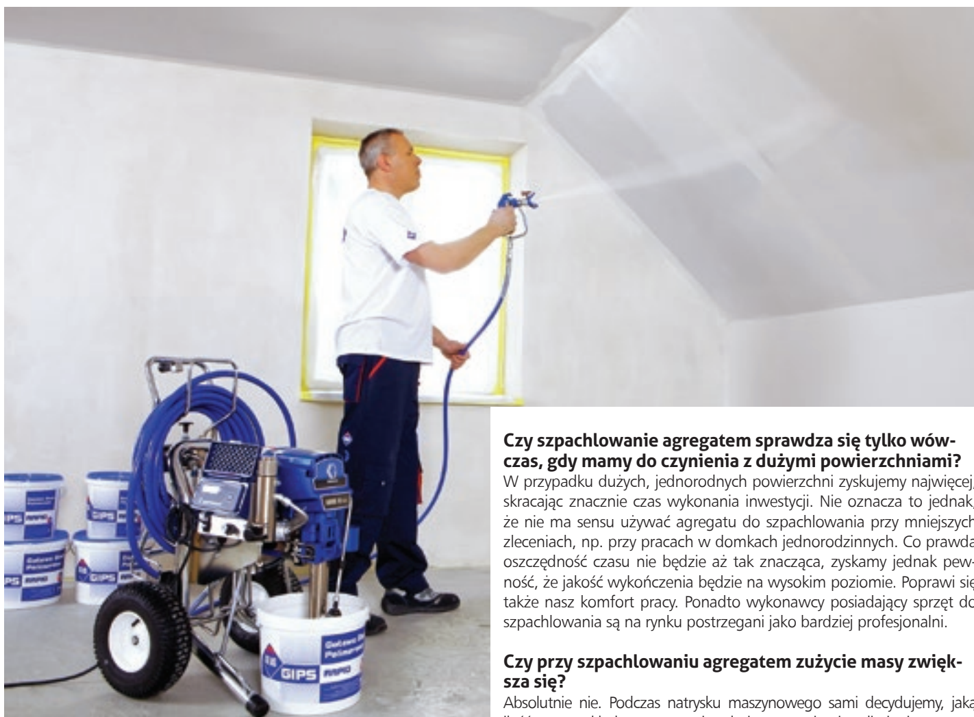
Fot. 1. Do szpachlowania maszynowego nadaje się większość mas gotowych stosowanych do aplikacji ręcznej.
