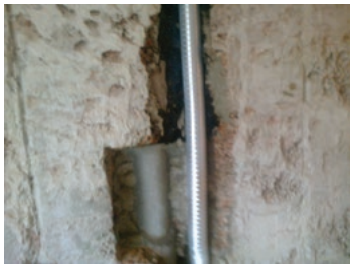
Fot. 5. Tu kiedyś próbowano zrobić komin dymowy dla kominka, jeden z otworów został w ogóle zamurowany (wentylacja piwnicy sąsiada). Odtworzony z pomocą rury spiro, po lewej stronie już po wzmocnieniu siatką i klejem.
