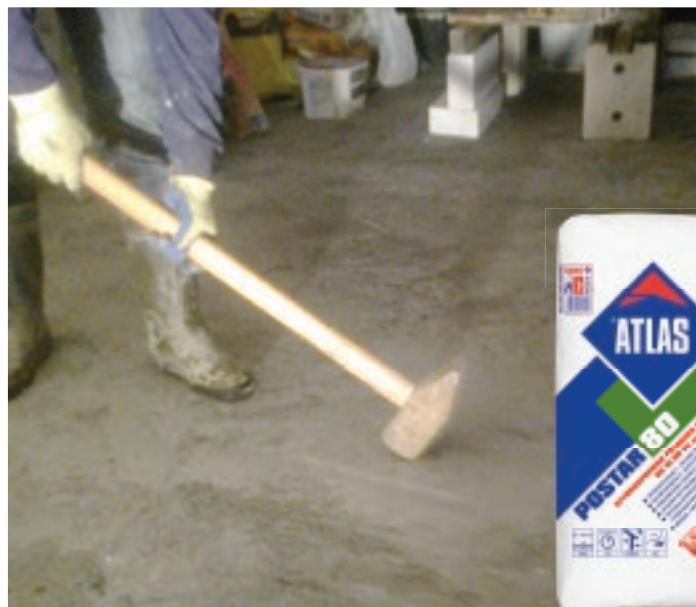
Fot. 4. W strefie garażowej podkład został wzmocniony zbrojeniem (siatka z oczkiem 10x10 cm). Materiał, który wykorzystałem do wykonania posadzki to ATLAS Postar 80 wylewany za pomocą miko-kreta. Próba uderzenia młotem wykonana po 10 godz. od momentu wykonania pracy.
