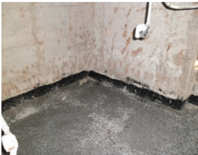
Fot. 3. Keramzyt zagęszczony i gotowy, aby „trzymać” ciepło.
