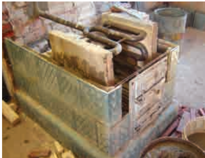
Fot. 2. Ściany składają się z kafli ściśle wylepionych wewnątrz za pomocą ogniotrwałą oraz z futrówki, czyli z wewnętrznego wyłożenia płytami szamotowymi.
