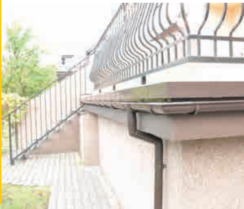
Fot. 1. Teras z zastosowaniem profilu ATLAS 300. Kolor – brązowy.
