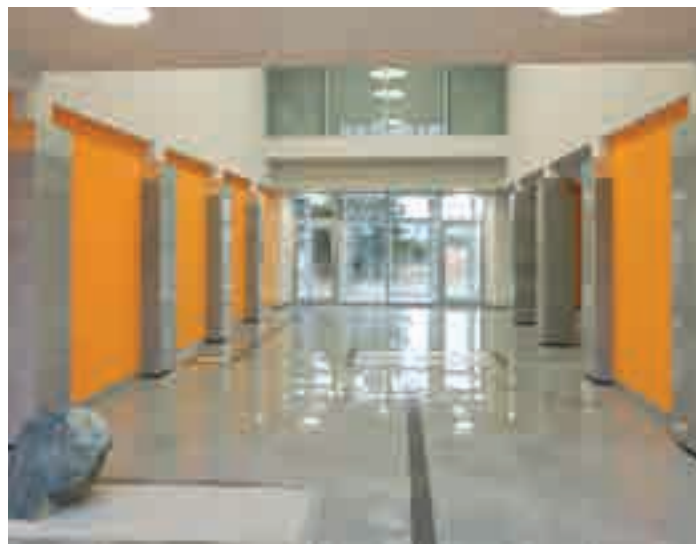
Fot. 5. Barwniki w stiukach akrylowych są intensywne, natomiast te w stiukach wapiennych – pastelowe, stonowane.
