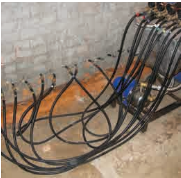
Fot. 3. W metodzie ciśnieniowej należy zapewnić utrzymanie się ciśnienia w murze przez określony czas.
