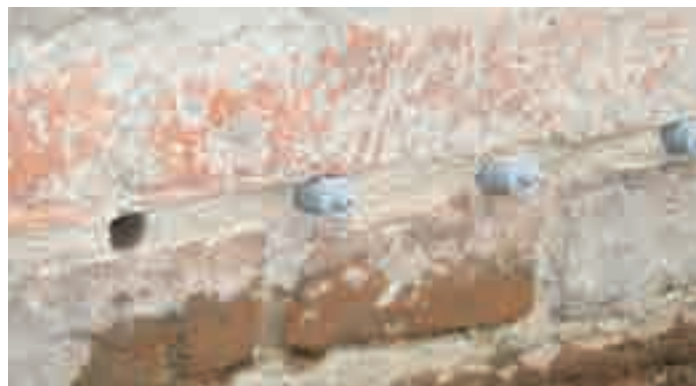
Fot. 4. W otworach umieszczamy tzw. pakery iniekcyjne, pozwalające wprowadzić preparat pod ciśnieniem.
