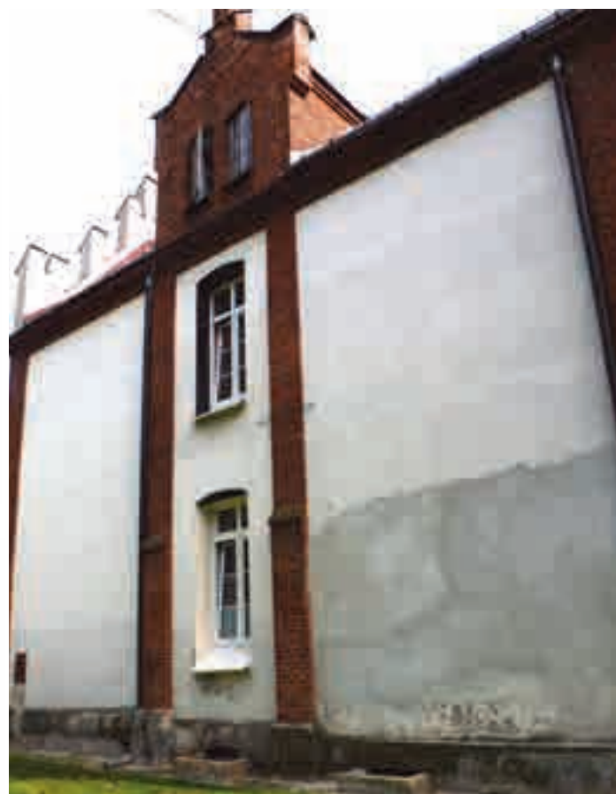
Fot. 3. Zdjęcia ściany piwnicznej i elewacji budynku. Widoczny brak skutecznych izolacji poziomych i pionowych. Kapilarne podciąganie wody i zniszczenie tynków na elewacji. Widoczne ślady nieskutecznych napraw tynków przy pomocy tradycyjnych tynków cementowo-wapiennych.
