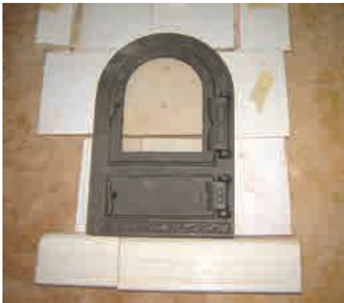
Fot. 4. Żeliwną i stalową armaturę piecową (drzwiczki) dawniej grafitowano, była to specjalna pasta grafitowa lub proszek grafitowy wymieszany z piwem, wcierany w powierzchnię odlewów stalowych.
