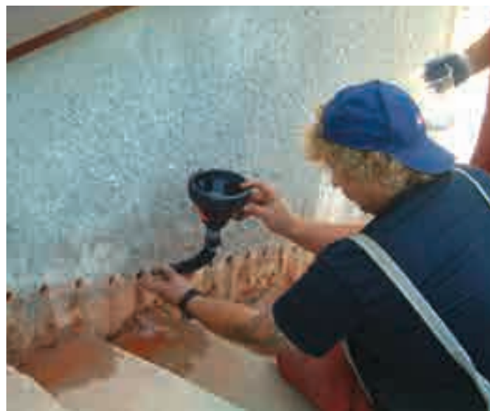
Fot. 2. W przypadku iniekcji grawitacyjnej preparat wlewamy do otworów aż do pełnego nasycenia muru.
