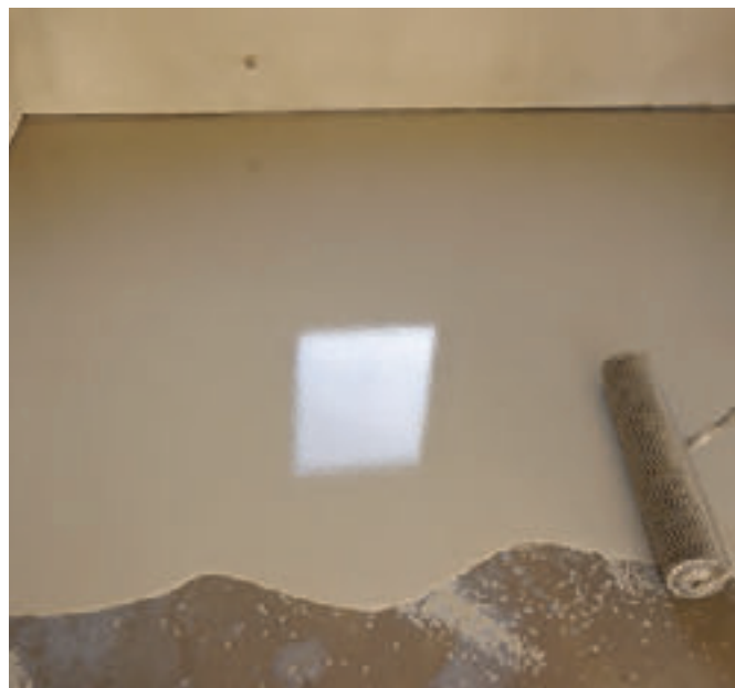
Fot. 4. Ujednolicanie i odpowietrzanie zaprawy przy użyciu wałka siatkowego
