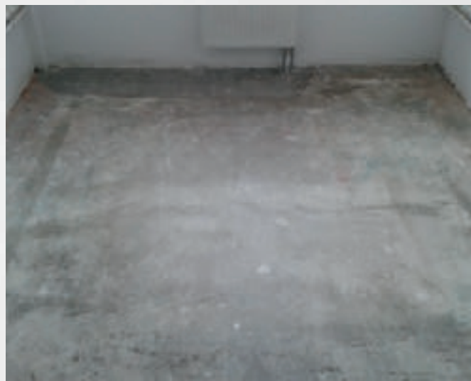
Fot. 1. Gruntowanie wykonane z użyciem emulsji ATLAS Uni-Grunt
