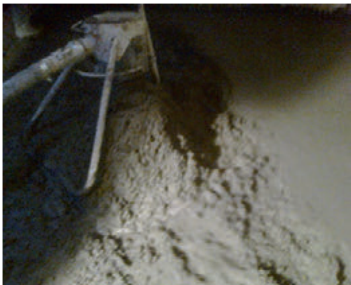
Fot. 1. Sposób układania kopców: tuż przy krawędzi gotowej posadzki, mniej pracy dla łaciarza przy rozprowadzaniu
