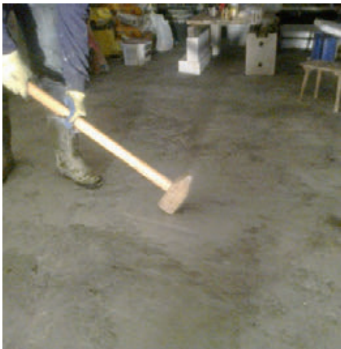
Fot. 3. Próba młota po ok. 10 godz. od wykonania wylewki. Wyraźnie widać jednolitą strukturę
