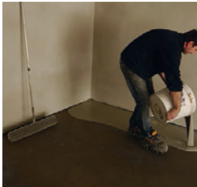
Fot. 3. Wylewanie zaprawy powinno się wykonywać równomiernymi warstwami od ściany najdalej oddalonej od wejścia
