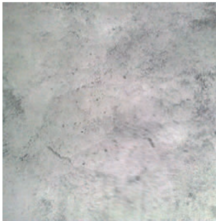
Fot. 4. Posadzka po 10 dniach od wylania: brak rozwarstwień, odspojień, pęknięć. Uruchomione ogrzewanie podłogowe
