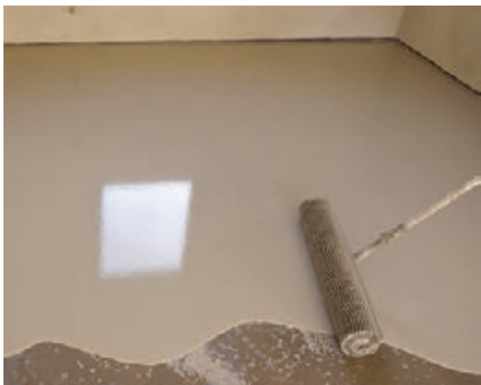
Fot. 1. Poziomowanie masy przy użyciu „kolczaka” tuż po wylaniu w prostopadłych kierunkach
