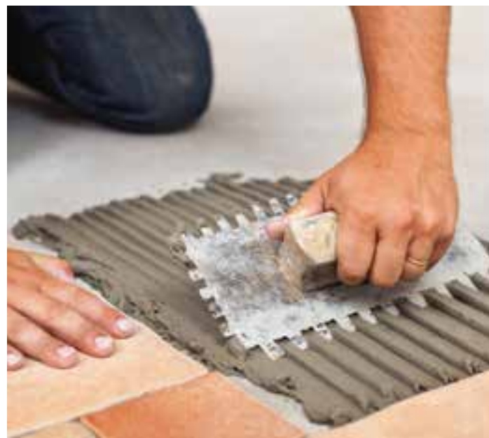
Fot. 2. Alternatywą do wyrównania podłoża może być stosowanie klejów grubowarstwowych
