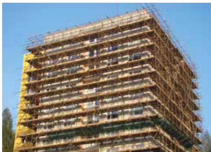
Fot. 1. Rusztowanie rurowo-złączkowe
