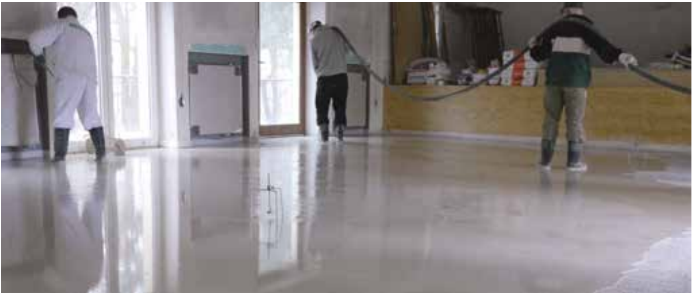
Fot. 2. Maszynowa aplikacja podkładów szybkosprawnych na bazie anhydrytu doskonale sprawdza się na dużych powierzchniach (powyżej 15 m 2 )
