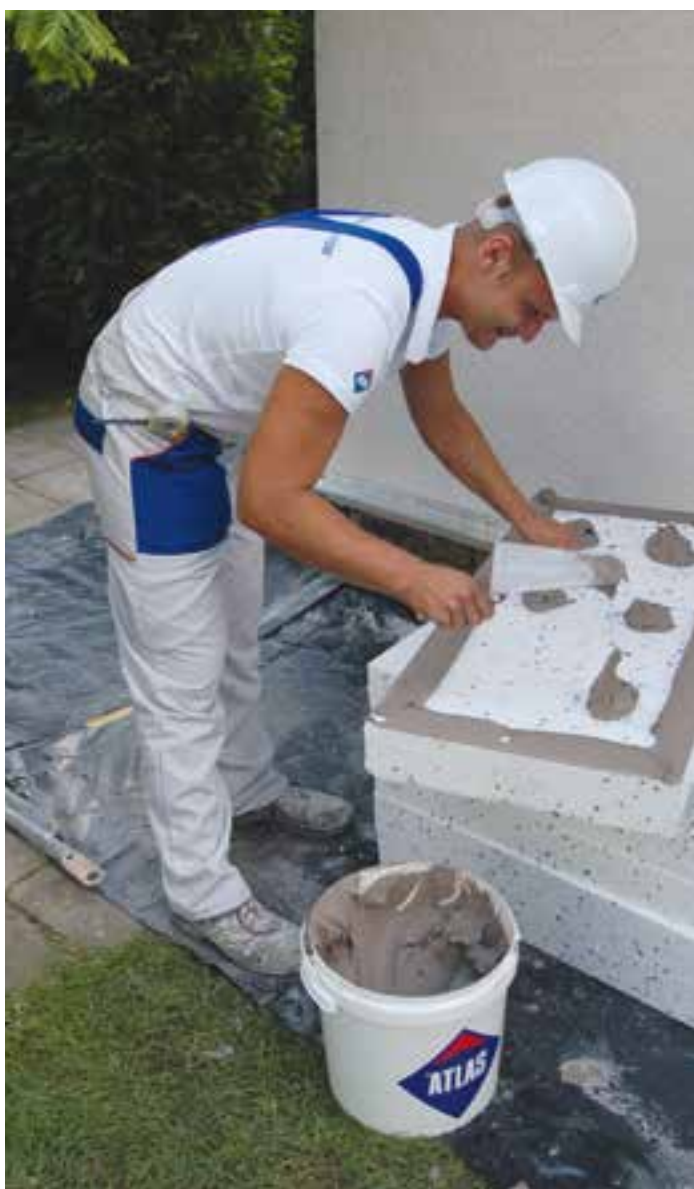
Fot. 1. Nakładanie kleju ATLAS Stopter metodą „obwodowo-punktową”
