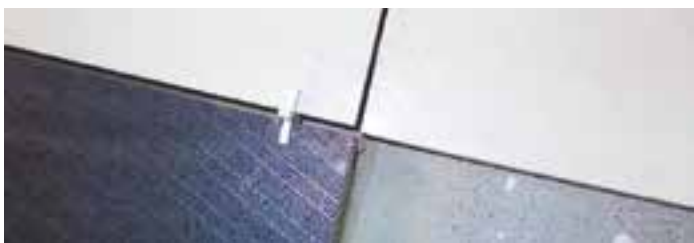
Fot. 1. Różnice w kalibracji są często spotykane w przypadku płytek II gatunku
