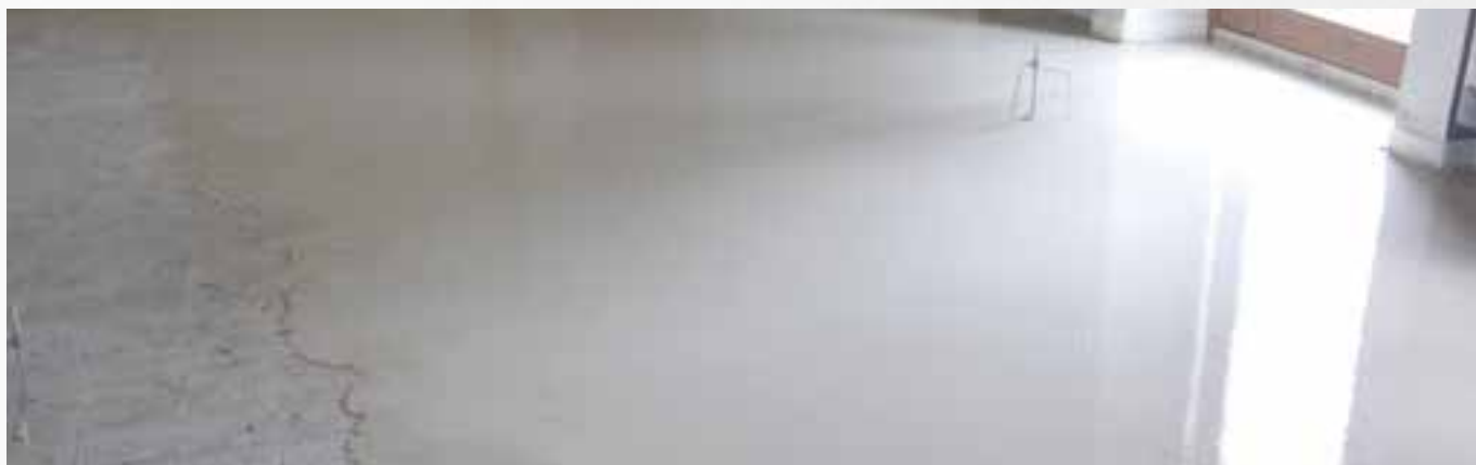
Fot. 1. Maszynowe wylewanie samopoziomującego podkładu podłogowego na starym podłożu betonowym
