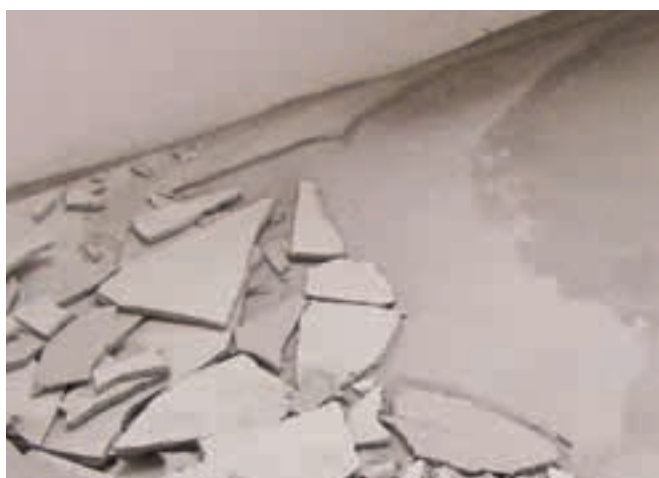
Fot. 4. Odspojenie podłoża
