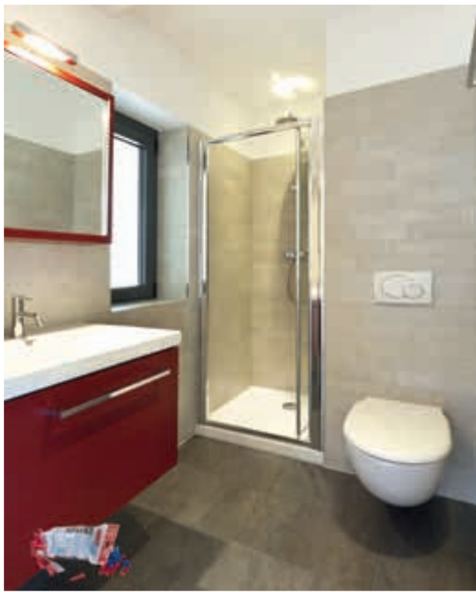
Fot. 1. Płytki ceramiczne w pomieszczeniach mokrych mogą być przyklejane na tynkach gipsowych w odpowiednich warunkach
