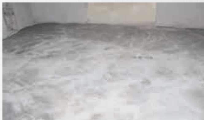
Fot. 1. Zgorzel na powierzchni podkładu podłogowego
