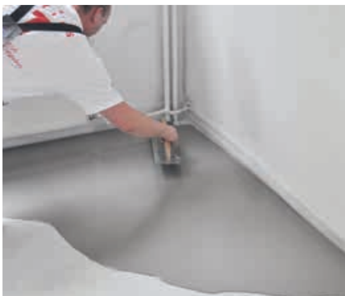
Fot. 1. Wyrównywanie samopoziomującej masy ATLAS SMS 30
