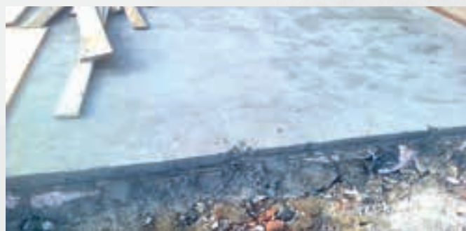
Fot. 2. Zgorzel na powierzchni podkładu podłogowego
