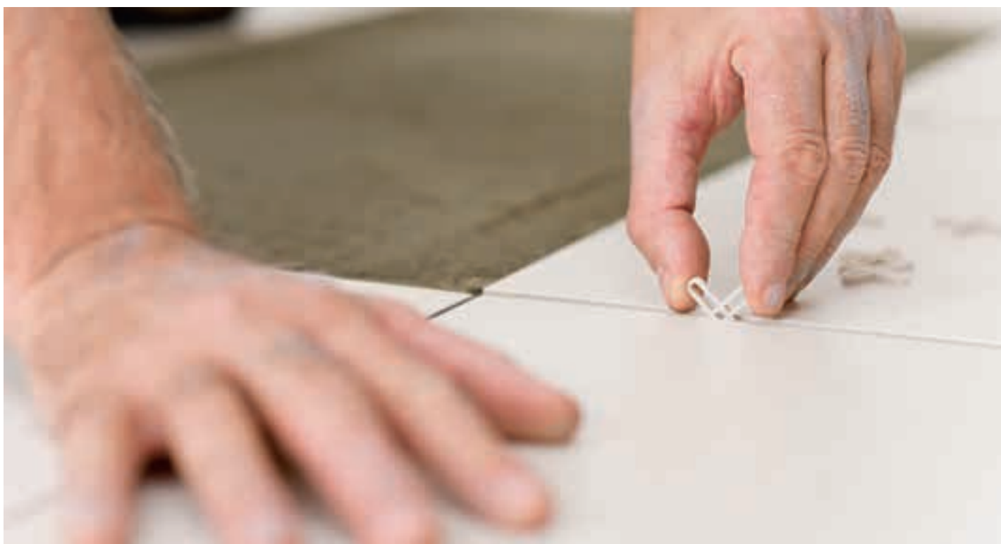
Fot. 1. Dopuszczalne odchylenie spoin od linii prostej nie powinno być większe niż 2 mm/1 m
