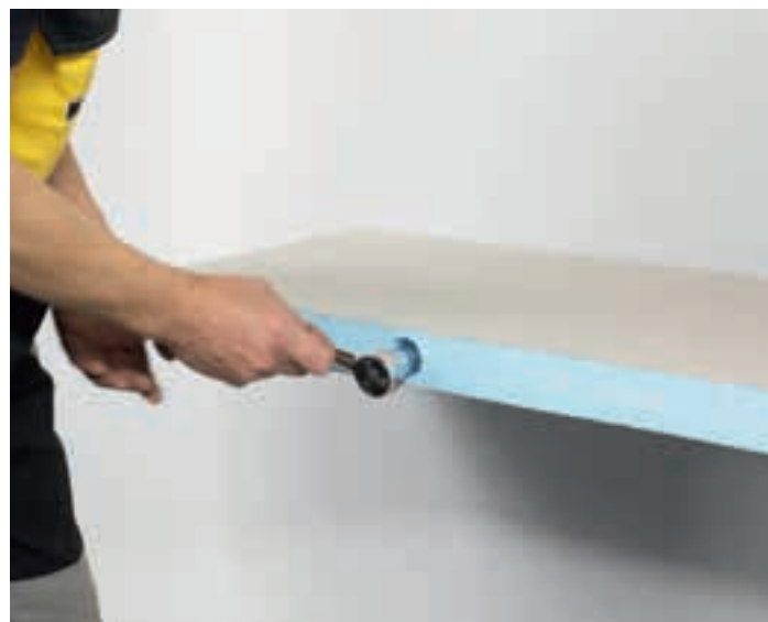
Fot. 2. Otwory należy nawiercać, zachowując odległość 250–300 mm
