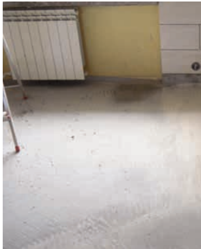
Fot. 8. Zastosowanie zbyt małej ilości wody spowodowało trudności z wygładzeniem warstwy szpachlowej
