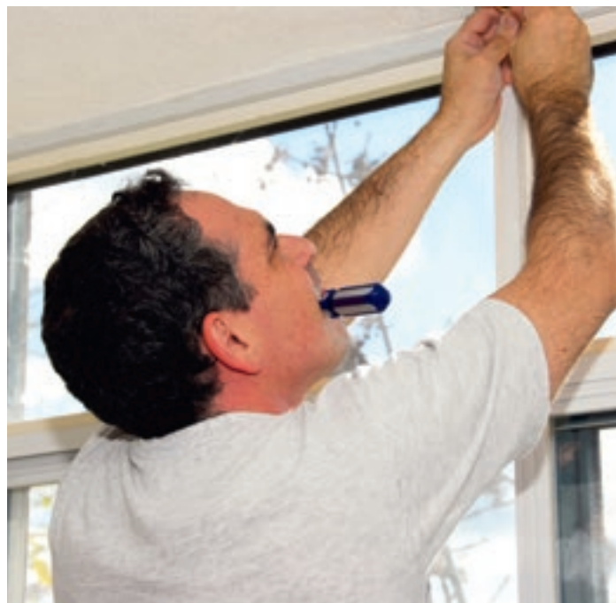
Fot. 2. Żeby prawidłowo osadzić ościeżnicę, stabilizuje się ją za pomocą plastikowych lub drewnianych klinów mocujących
