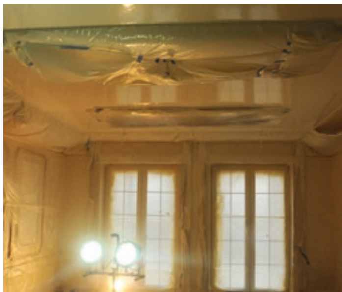
Fot. 3. Zdjęcie pokazuje, jak obciążona mokrą farbą folia samoczynnie odkleja się od sufitu. Chwilę później folia z gęstniejącą farbą przykleja się do ściany, na szczęście zabezpieczonej
