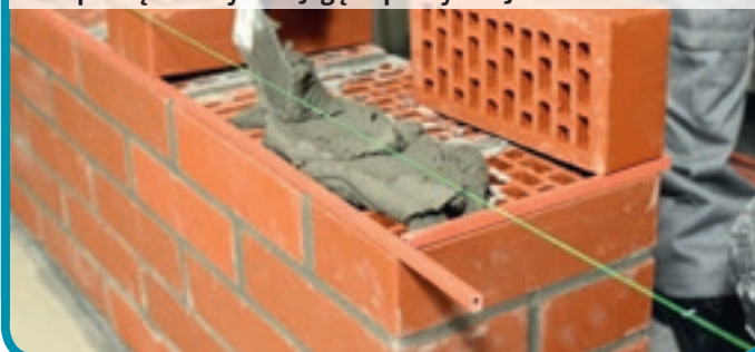
Fot. 1. Kolejne warstwy murowanej fasady powinny być wykonane zaprawą o konsystencji gęstoplastycznej
