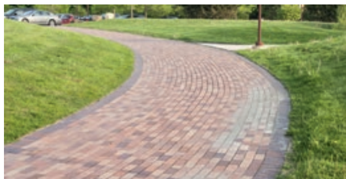
Fot. 10. Zastosowanie bruku klinkierowego
