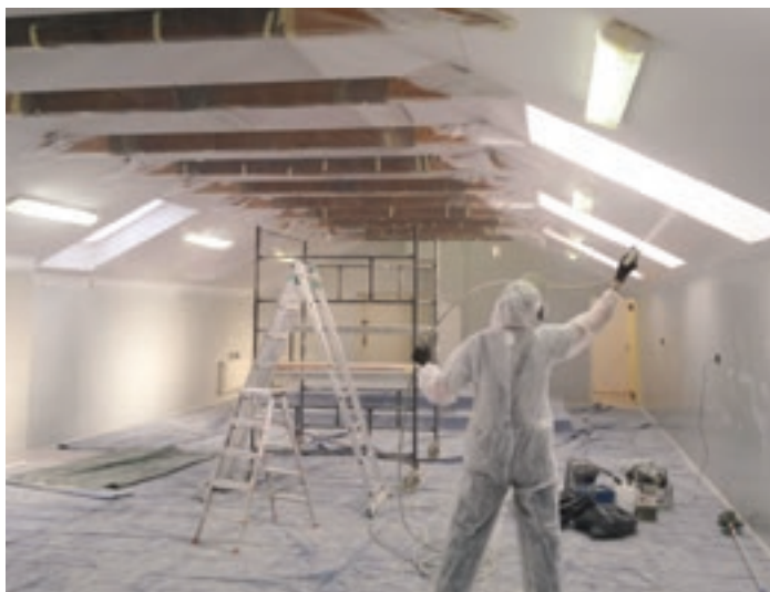
Fot. 1. Przy malowaniu natryskowym kolejno najpierw malujemy ściany, później sufit
