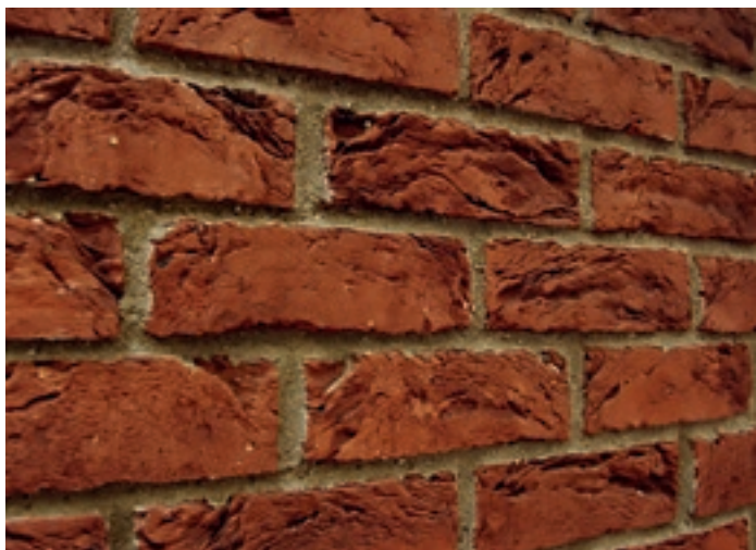
Fot. 7. Elewacja – płytki ręcznie formowane – Alt Mass
