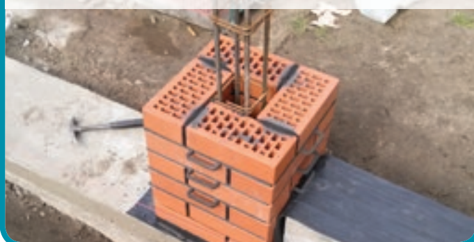
Fot. 2. Murowanie ogrodzenia
