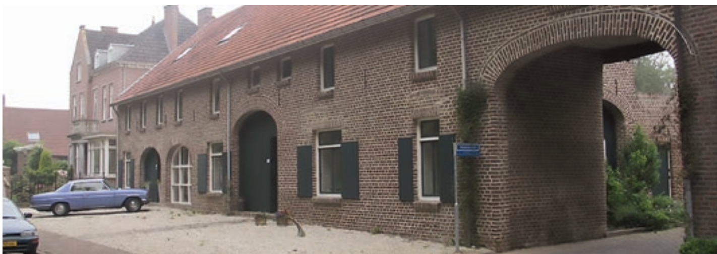
Fot. 1. Elewacje ceglane
