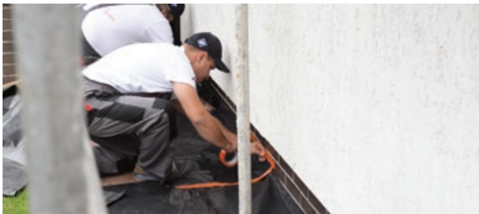
Fot. 3. Większe powierzchnie, takie jak pozbruk, należy przykryć grubą folią budowlaną
