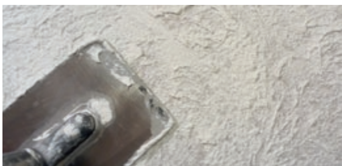
Fot. 1. Wykonywanie półkolistych ruchów na powierzchni piaskowca tworzy piękne, nieregularne wzory
