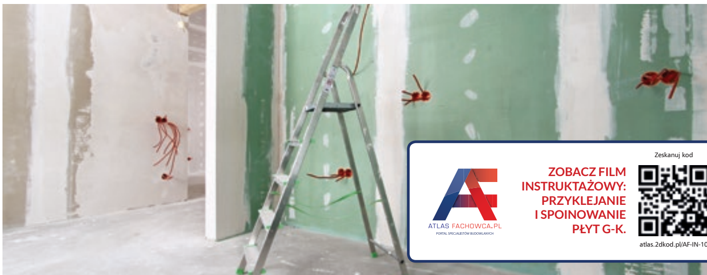
Fot. 1. W pomieszczeniach mokrych zaleca się stosowanie impregnowanych płyt g-k (zielonych)
