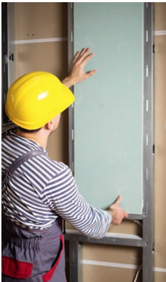
Fot. 1. Spękania płyt g-k mogą wynikać z nieprzestrzegania zasad prawidłowego montażu stelaża
