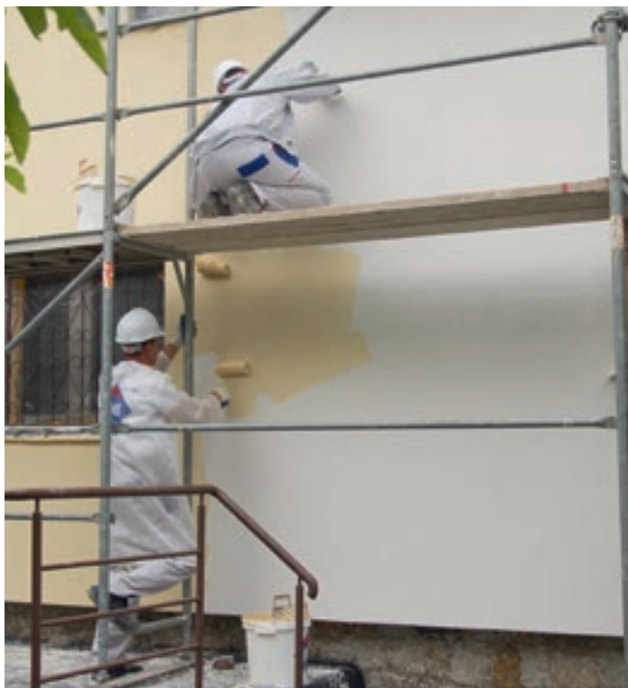
Fot. 1. Malowanie tynku mineralnego farbą elewacyjną
