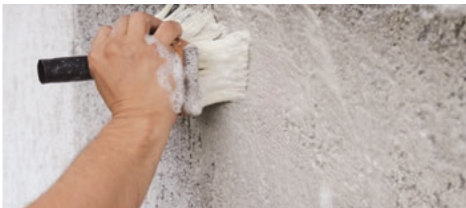
Fot. 4. Przed malowaniem powierzchnię trzeba dokładnie oczyścić
