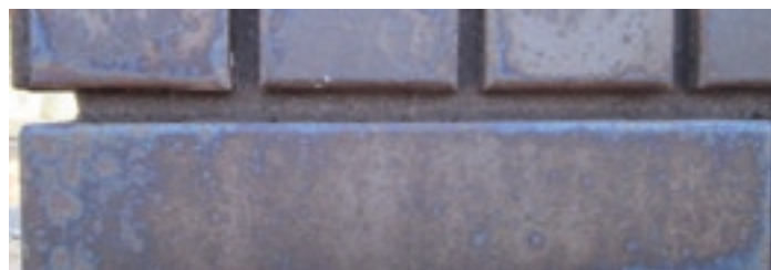
Fot. 3. Wykitty mogą występować w postaci oleistych plam zwanych kręgami Newtona. Mogą przybierać różne kolory, najczęściej są jednak białe. Próbę ich wyczyszczenia najlepiej przeprowadzić na małym fragmencie muru
