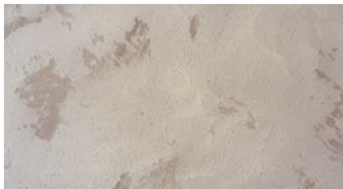
Fot. 3. Efekt uzyskany dzięki nakładaniu materiału kantem pacy
