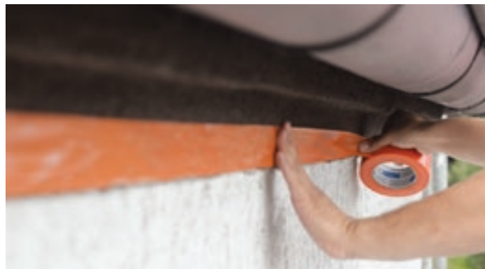
Fot. 2. Taśmą zabezpiecza się te elementy, które bezpośrednio stykają się z tynkiem, a których nie można zdemontować
