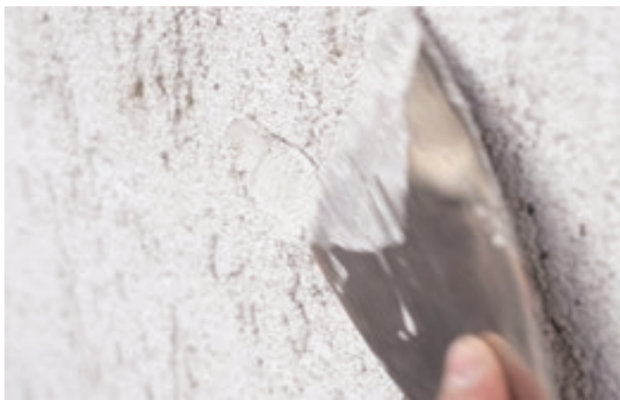
Fot. 5. Odtwarzanie wzoru szpachelką w miejscu ubytku
