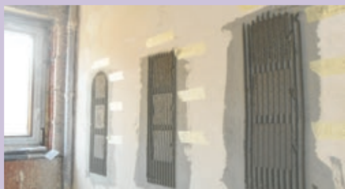
Fot. 2. Przyczepność do podłoża badana w różnych odstępach czasu po położeniu płytki na ścianie
