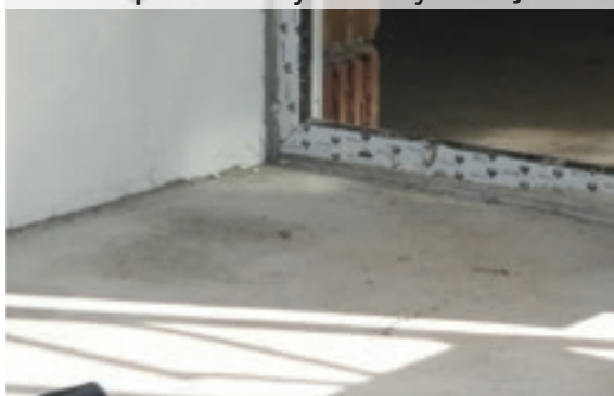
Fot. 1. Staranne wykonanie detali przy drzwiach umożliwia prawidłowe wykonanie hydroizalacji
