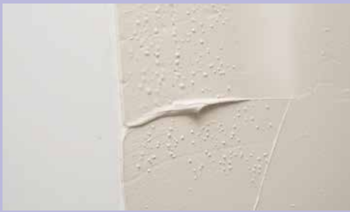
Fot. 5. Bąblowanie przy drugiej warstwie gładzi
