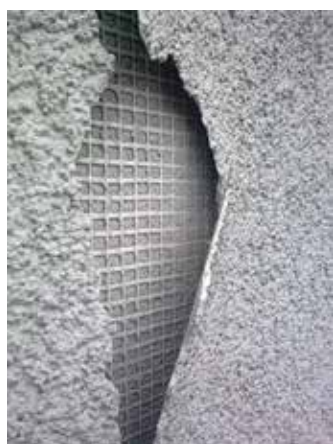
Fot. 1 a i b. Przykłady źle zatopionej siatki. Tynk odspoił się razem z warstwą zbrojącą (przyczyny tego zjawiska mogą być różne – nieostoięta elewacja, nieprawidłowo wykonane szpachlowanie)
