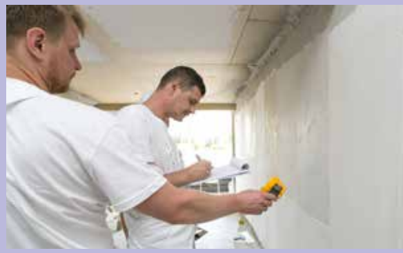
Fot. 2. Badanie temperatury podłoża, na które nakładana jest gładź. Prawidłową temperaturę do nakładania gładzi określają Karty Techniczne Produktu (w przypadku gładzi temp. wynosi między 5 a 25°C)
