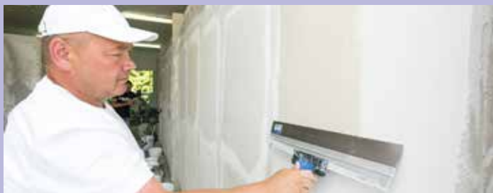
Fot. 4. Wygładzanie piórem
