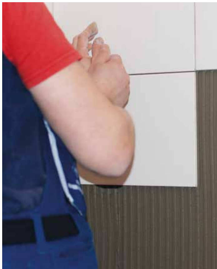
Fot. 3. ATLAS Plus, jako klej typu C2, posiada zwiększoną przypięność – dwukrotnie większą niż kleje typu C1
