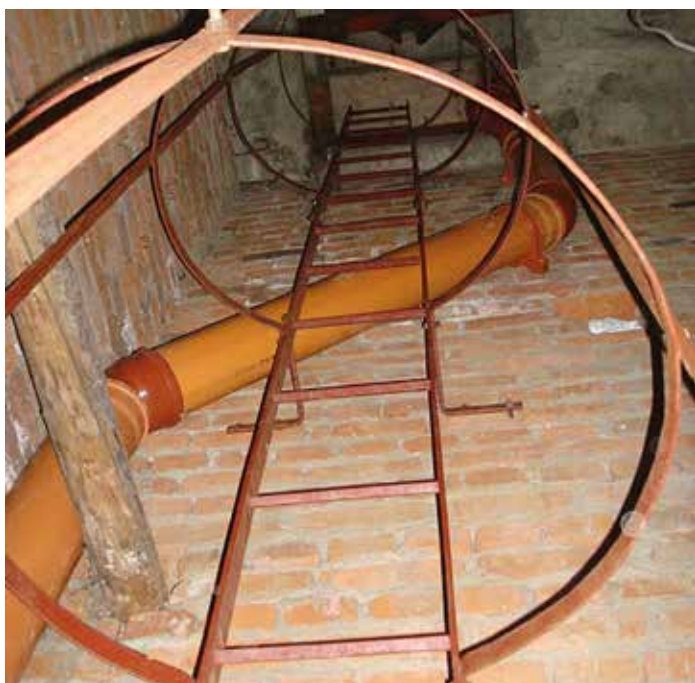
Fot. 2. Wykonanie instalacji wentylacji grawitacyjnej w obiekcie zapobiegnie pojawieniu się zagrzybienia w przyszłości
