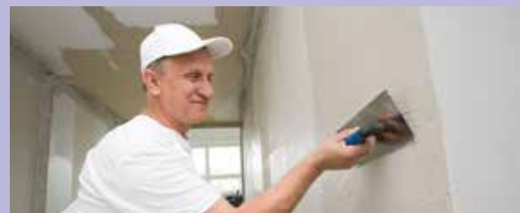
Fot. 3. Nakładanie drugiej warstwy gładzi
