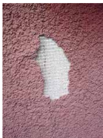
Fot. 1 a i b. Przykłady źle zatopionej siatki. Tynk odspoił się razem z warstwą zbrojącą (przyczyny tego zjawiska mogą być różne – nieostoięta elewacja, nieprawidłowo wykonane szpachlowanie)
