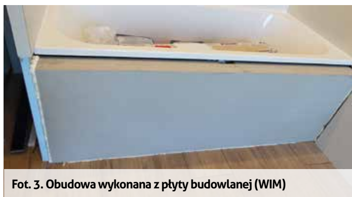
Fot. 2. Obudowa wanny wykonana z płyty budowlanej
