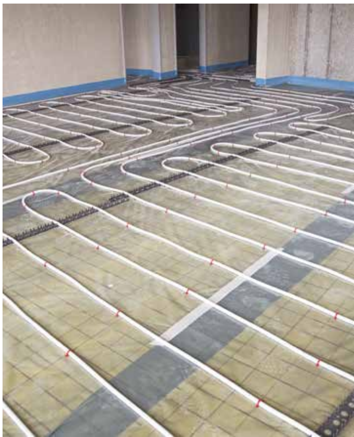
Fot. 2. Klej ATLAS Plus można bezpiecznie zastosować tam, gdzie wymagany jest klej wysokoelastyczny, np. na ogrzewaniu podłogowym
