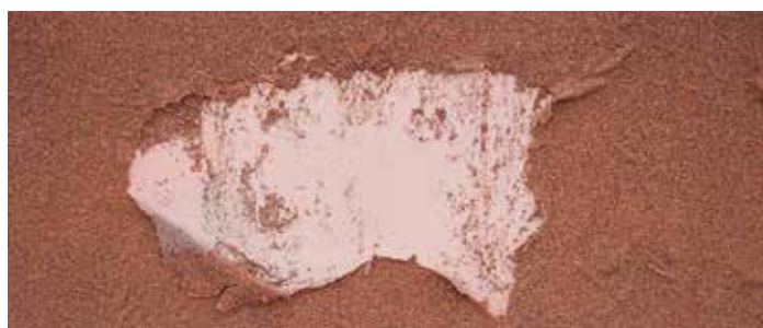
Fot. 1 a i b. Przykłady źle zatopionej siatki. Tynk odspoił się razem z warstwą zbrojącą (przyczyny tego zjawiska mogą być różne – nieostoięta elewacja, nieprawidłowo wykonane szpachlowanie)
