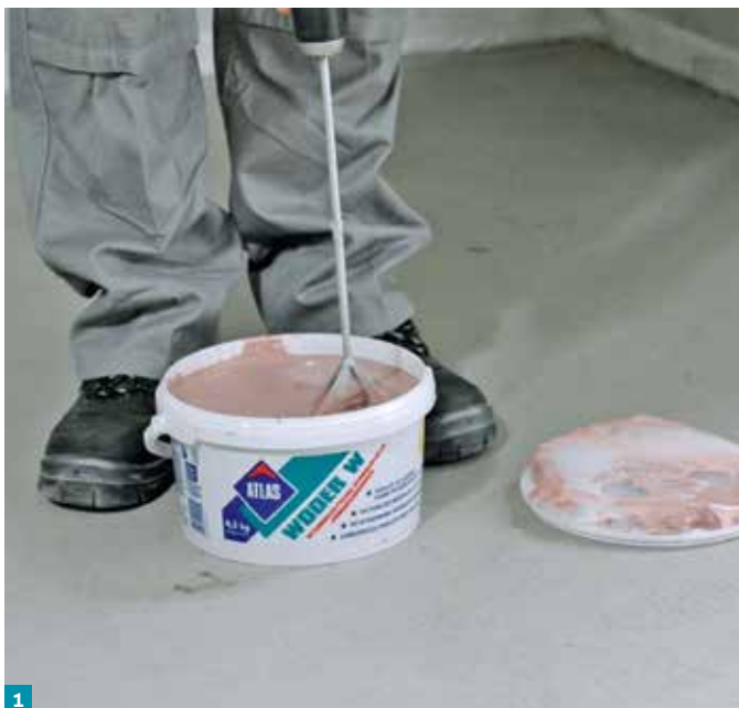
1 Po otwarciu wiadra z ATLAS Woder W zawartość należy wymieszać w celu wyrównania konsystencji (zaleca się stosowanie wiertarki wolnoobrotowej).
