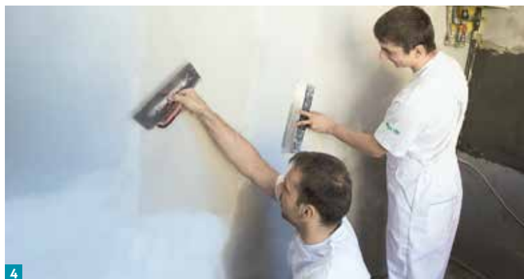
4 Co dwie głowy, to nie jedna – ocena jakości robót podczas „naciągania” drugiej warstwy.
