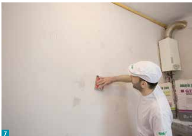
7 Próba ręcznego szlifowania gładzi.
