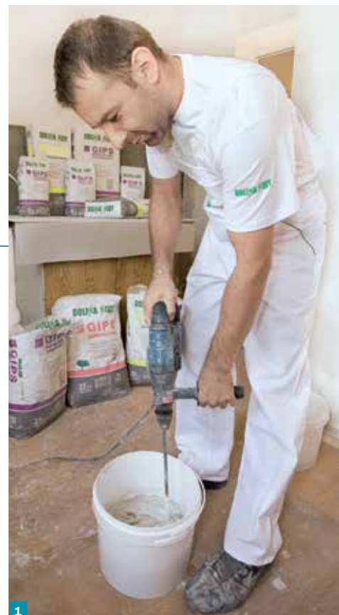
1 Ocena konsystencji i urabialności jednej z trzech prób gładzi.
