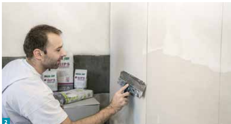
2 Nakładanie gładzi na wydzielonych poletkach testowych.
