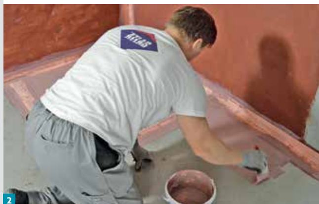
2 Wcieranie pędzlem jest najlepszym sposobem na nałożenie pierwszej warstwy folii w płynie ATLAS Woder W.
