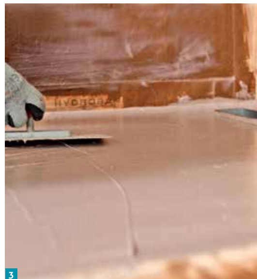
3 Nakładanie drugiej warstwy hydroizolacji ATLAS Woder W pacą stalową.
