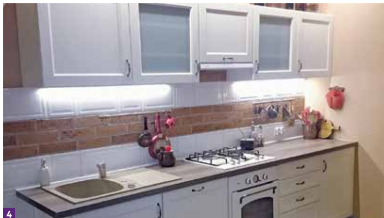
Między blatem a szafkami zastosowałem stare płytki o oryginalnym kształcie, które pochodziły z rozbiórki.
