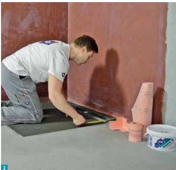
2 Przygotowanie podłoża przed założeniem ATLAS Woder W.
