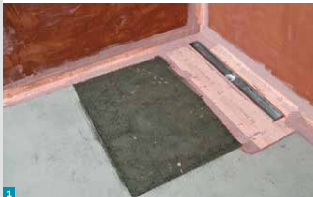
1 Taśmy ATLAS Hydroband 3G po zamocowaniu w narożniku łazienki.
