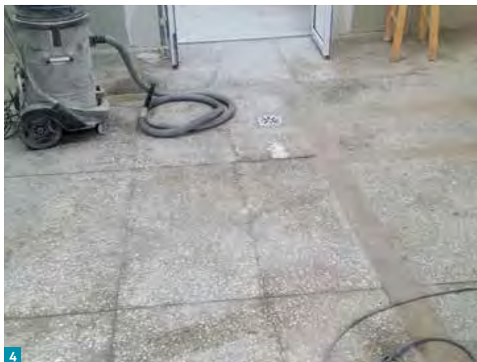
Posadzka przed położeniem powłoki epoksydowej.
