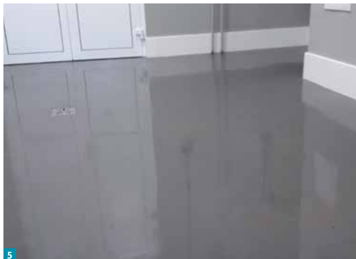
Posadzka z produktów na bazie żywic epoksydowych.
