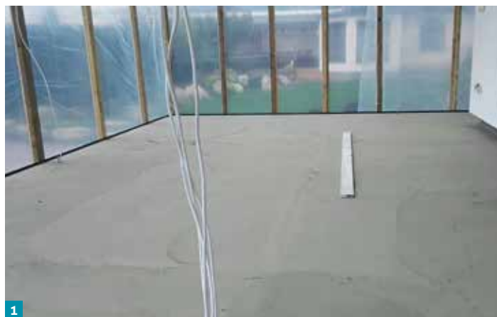
Warstwa zaprawy uszczelniającej na tarasie. Taras został dodatkowo zabezpieczony przed opadami „namiotem”, który chroni hydroizolację przed wilgocią podczas jej wysychania. Zdjęcie: firma Renoplast
