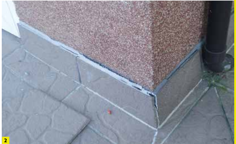
Zdjęcia 1 i 2 – odspojenie okładziny. Widoczny brak połączenia między podłożem a płytkami. Proces wiązania cementu w kleju nie nastąpił prawidłowo. Warunki otoczenia i nieprawidłowo przygotowane podłoże wpłynęły negatywnie na wiązanie cementu. Doszło do zmniejszenia przyczepności, wytrzymałości zaprawy i zerwania połączenia między podłożem a okładziną.
