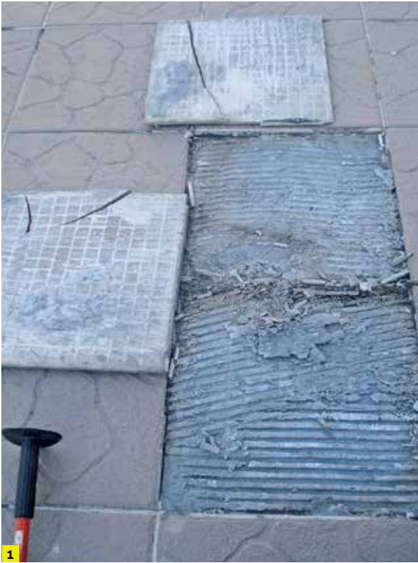
Zdjęcia 1 i 2 – odspojenie okładziny. Widoczny brak połączenia między podłożem a płytkami. Proces wiązania cementu w kleju nie nastąpił prawidłowo. Warunki otoczenia i nieprawidłowo przygotowane podłoże wpłynęły negatywnie na wiązanie cementu. Doszło do zmniejszenia przyczepności, wytrzymałości zaprawy i zerwania połączenia między podłożem a okładziną.
