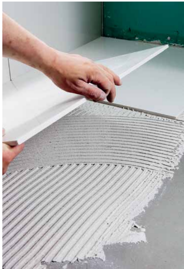
Przyklejanie płytek dużego formatu bez ogrzewania podłogowego – wypełnienie pod płytką 70%. Klej ATLAS Plus Mega Białego nałożony pacą prostokątną.
