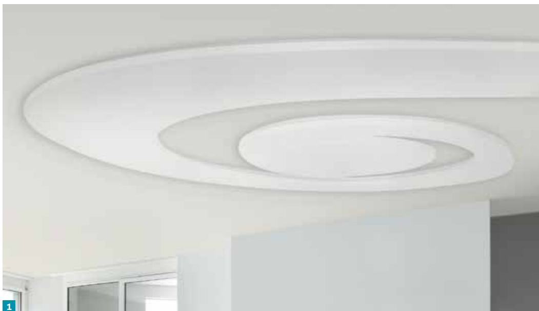
1 Sufit wykonany na konstrukcji M-System.
