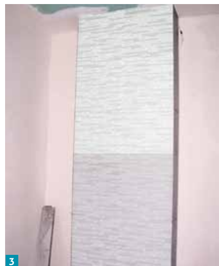
3 Przykład zmiany wyglądu i koloru mozaiki szklanej – górny fragment okładziny ułożono za pomocą białego kleju, natomiast dolny na kleju szarym.
