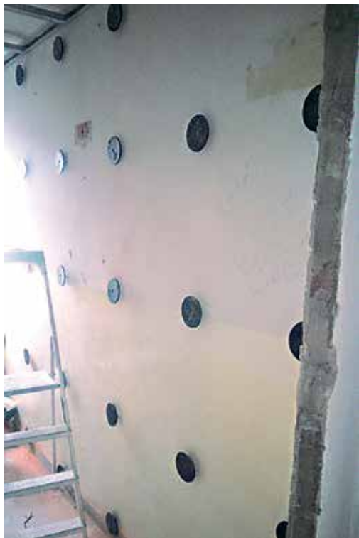
Jeśli dokręcimy krążki do płaszczyzny i damy płytę kartonowo-gipsową o grubości 12,5 mm, to zabieramy z pomieszczenia tylko 2,5 cm.
