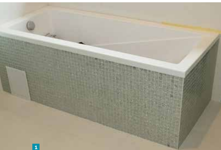
1 Przykład zmiany wyglądu i koloru mozaiki szklanej. Mozaika położona na obudowie wanny (fot. 1) wygląda prawidłowo, wygląd mozaiki na ścianie kabiny prysznicowej (fot. 2) jest nieprawidłowy.
