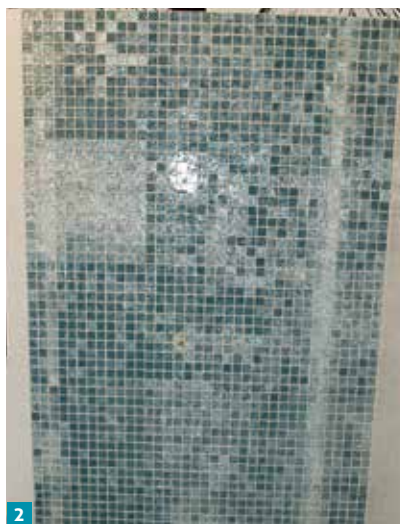
1 Przykład zmiany wyglądu i koloru mozaiki szklanej. Mozaika położona na obudowie wanny (fot. 1) wygląda prawidłowo, wygląd mozaiki na ścianie kabiny prysznicowej (fot. 2) jest nieprawidłowy.
