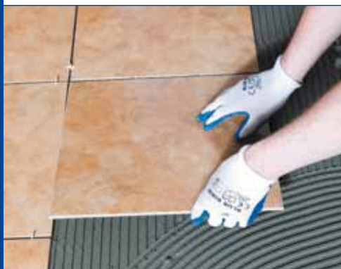
8b. Наклеивание плитки при помощи саморастекающегося клея
