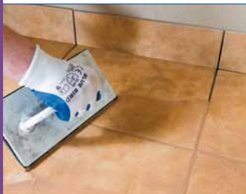
9a. Затирка швов цементной смесью для затирки швов
