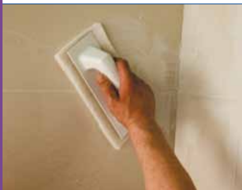
9b. Затирка швов при помощи эпоксидной смеси для затирки швов
