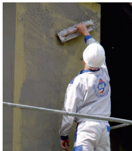
ПРИКЛЕИВАНИЕ СЕТКИ
