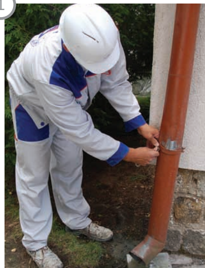
1 ДЕМОНТАЖ ВОДОСТОЧНОГО ЖЕЛОБА
