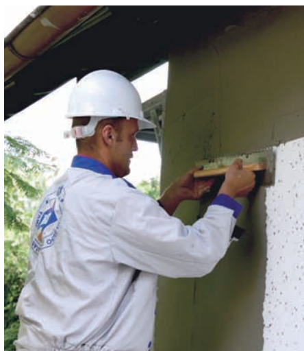
НАНЕСЕНИЕ КЛЕЯ НА ПЕНОПОЛИСТИРОЛ
