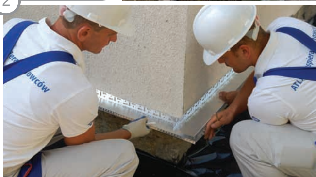
2 МОНТАЖ ЦОКОЛЬНОГО ПРОФИЛЯ
