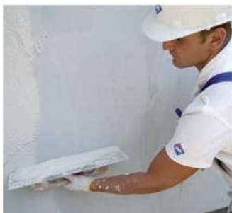
Нанесение штукатурки стальной теркой
