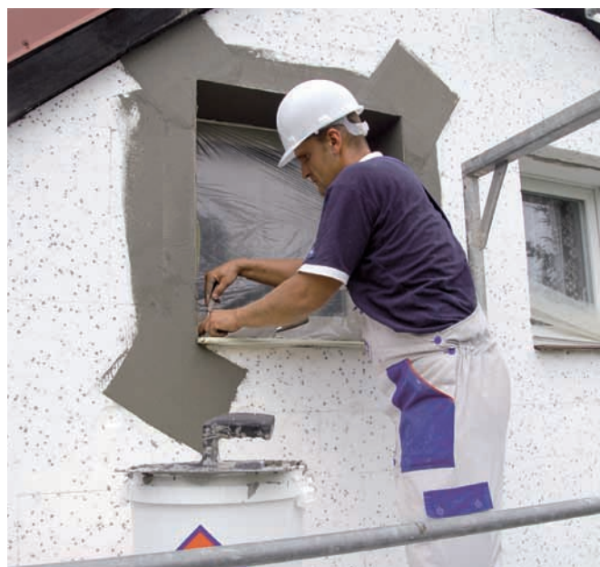
ОБРАБОТКА ОКОННОГО ПРОЕМА С ПРИМЕНЕНИЕМ ПРОФИЛЕЙ И СЕТКИ В ДИАГОНАЛЬНОЙ СИСТЕМЕ
