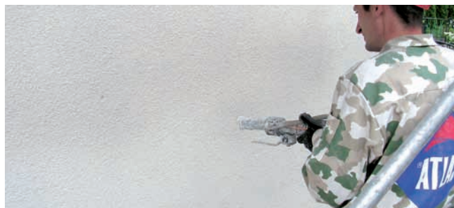
Нанесение штукатурки способом распыления
