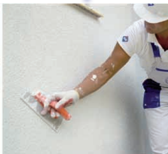
Нанесение штукатурки стальной теркой
