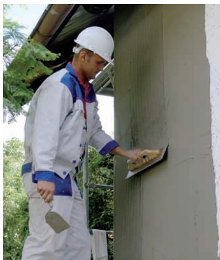
ПРОФИЛИРОВАНИЕ КЛЕЯ ЗУБЧАТОЙ ТЕРКОЙ
