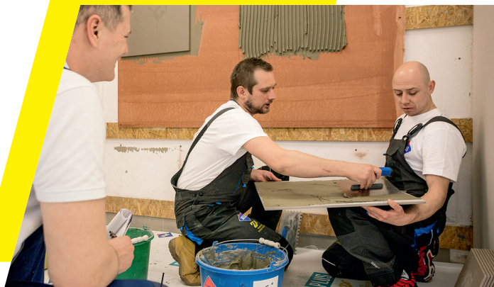
Po przyklejeniu dużej płytki Wykonawcy oceniali spływ.
