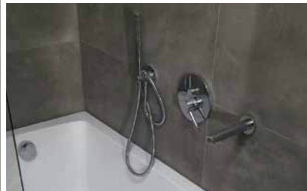
Bateria i słuchawka prysznica w zestawie podtynkowym wymagały zmian w hydraulice.
