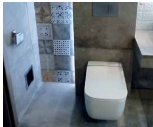
Zabudowa stelaża WC. W montażu najważniejsze jest prawidłowe ustalenie pionu i poziomu stelaża.
