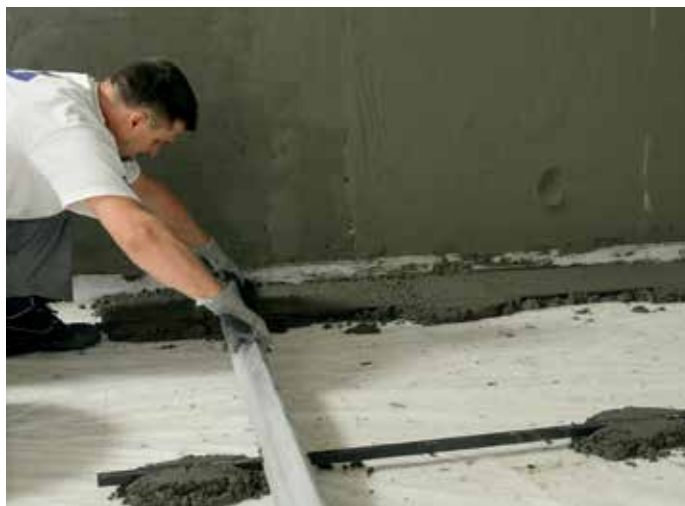
W uzyskaniu równej powierzchni podkładu lub posadzki pomaga zastosowanie metalowych listew kierunkowych.
