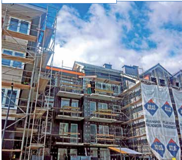
Podczas ocieplania wykorzystano kleje do stosowania w wysokiej temperaturze – ATLAS Hoter U i Hoter U2.
