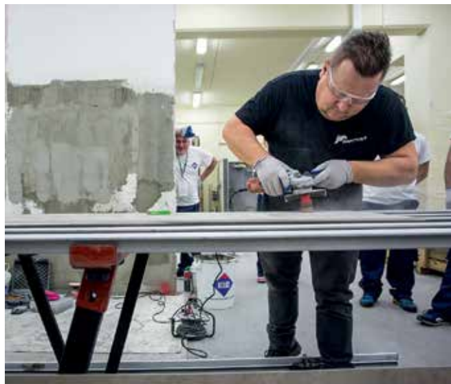
Przy pracach dodatkowych, takich jak np. wycinanie otworów, każdy błąd w wyliczeniach naraża nas na duże straty. Wszelkie zabiegi należy wykonywać wolniej i dokładniej.
