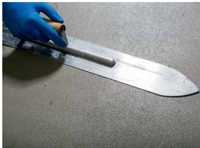
Wibrowanie – ubijanie podkładu cementowego aż do efektu tzw. wypocenia.
