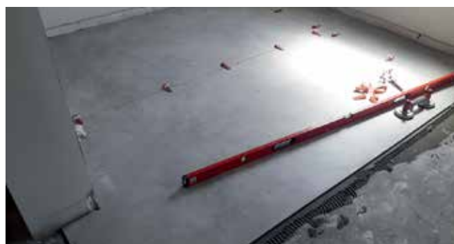
Tolerancja różnicy poziomów nie może przekraczać 3 mm na odcinku 2 m.
