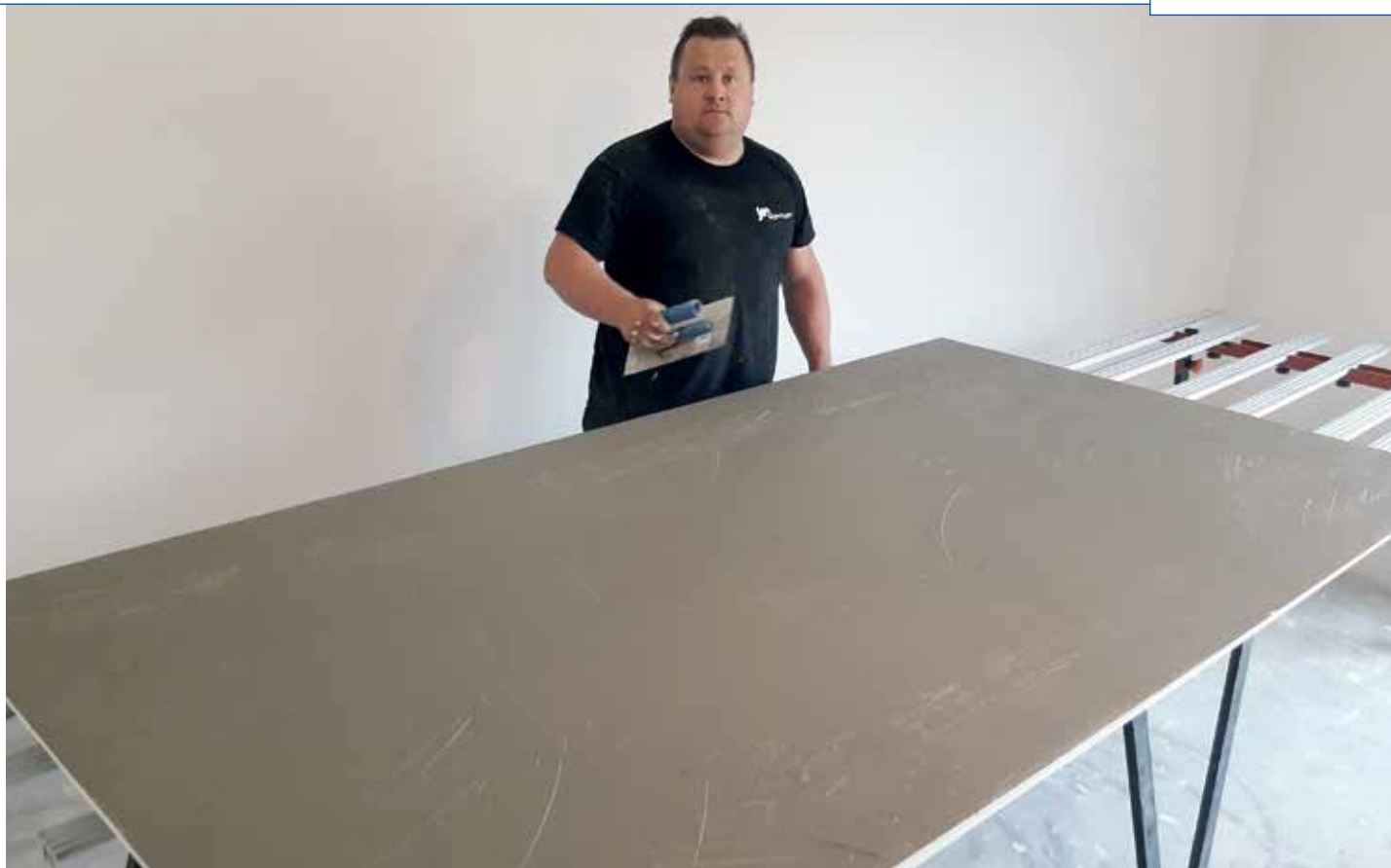
Odpowiednio duża przestrzeń w miejscu inwestycji zapewnia komfort pracy.
