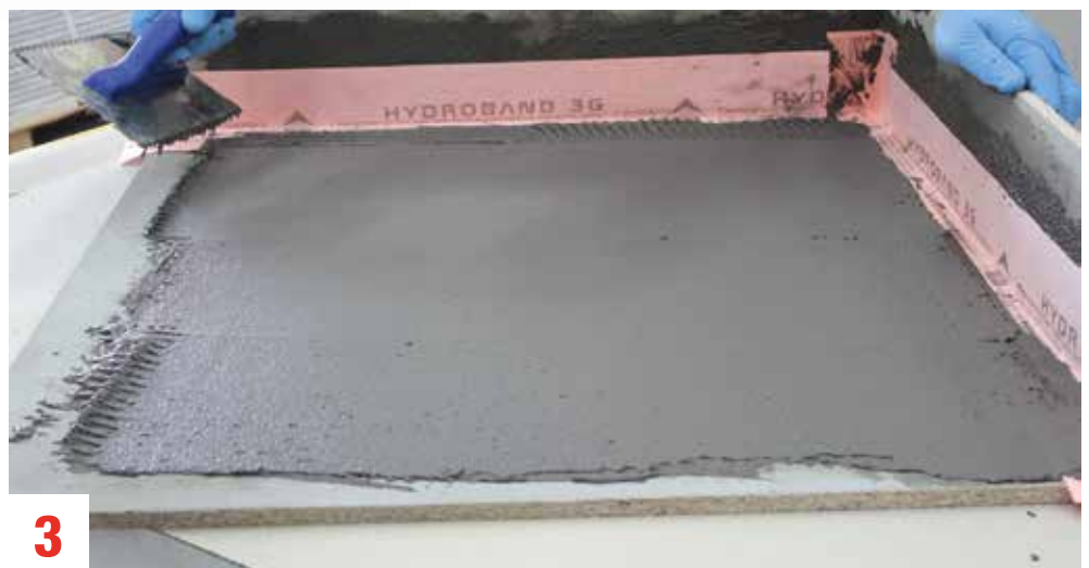
Wygładzenie masy gładką krawędzią pacy.
