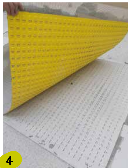
Mata kompensacyjna ATLAS po nałożeniu kleju PLUS S2Hydro. Po podniesieniu maty wyraźnie widoczne ślady kleju na podłożu w miejscu występowania perforacji. Takie mocowanie maty zapewnia brak przemieszczeń podczas jej montażu. Połączenie to zostanie łatwo odcięte od podłoża w razie pojawienia się odkształceń podłużnych.
