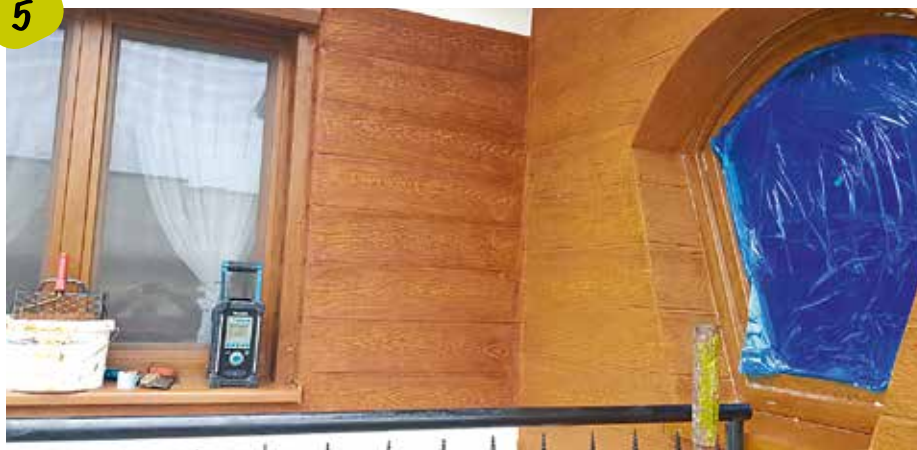
Forma jest silikonowa i dzięki temu można ją pociąć na krótsze elementy i odciskać w trudno dostępnych miejscach, np. takich jak glify w oknach.
