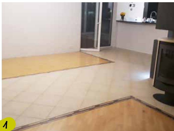
Salon: posadzki istniejące – widok przeszklenia od strony zachodniej z wyjściem na oranżerię. Płytki ceramiczne 40 x 40 cm ułożone na polu grzewczym, parkiet układany na podkładzie oddylatowanym.
