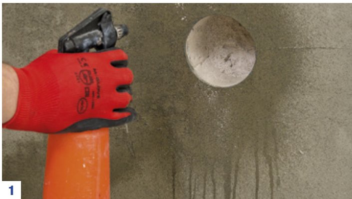
1 Zwilżenie podłoża przed przystąpieniem do montażu.
