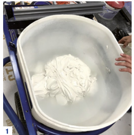
Zalana wodą gładź w agregacie.
