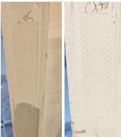
Pod obiema taśmami uzyskano bezproblemowe 100% wypełnienie łączenia.
