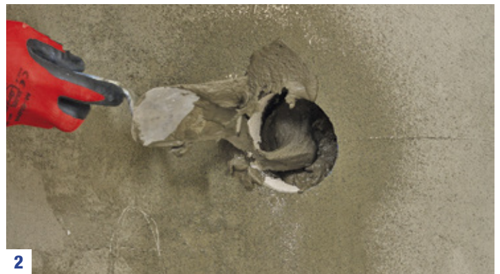
2 Nakładanie zaprawy ATLAS Monter T-5.
