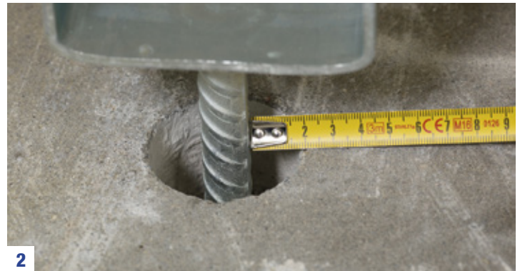
2 Weryfikacja szerokości szczeliny. Dla zaprawy ATLAS Monter T-5 może ona wynosić od 20 mm do 50 mm.
