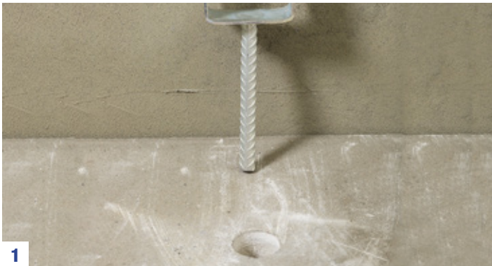
1 Przygotowanie otworu do zakotwienia.
