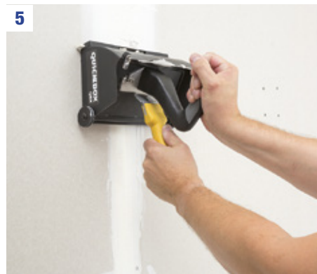
Skrzynka wykończeniowa Quick Box QB08-QSX z uchwytem krótkim 8000TT (zestaw przewidziany do materiałów proszkowych i dla początkujących z boksami).
