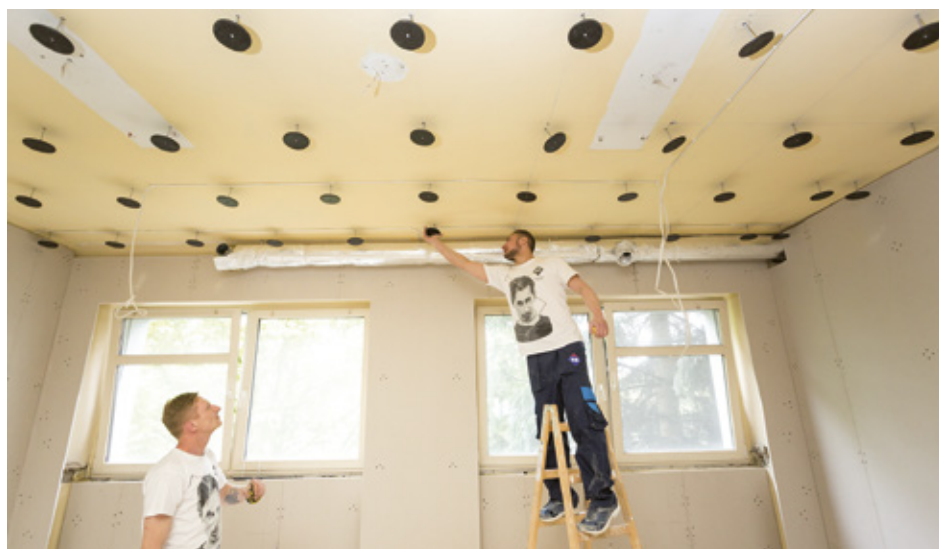
Na M-Systemie jest szybciej i da się idealnie wypoziomować krzywe ściany i sufity
