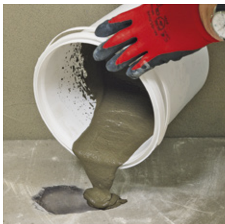
Wypełnianie ubytków w podkładach podłogowych.
