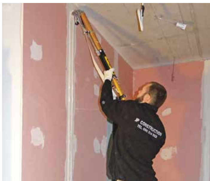
Równoczesne podawanie materiału i wklejanie taśmy oklejarką automatyczną TapeTech EasyClean.
