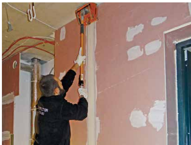
Narzędzia TapeTech i GTA w rękach specjalistów JP Construction. Na zdjęciu skrzynka wykończeniowa TapeTech MaxxBoss.
