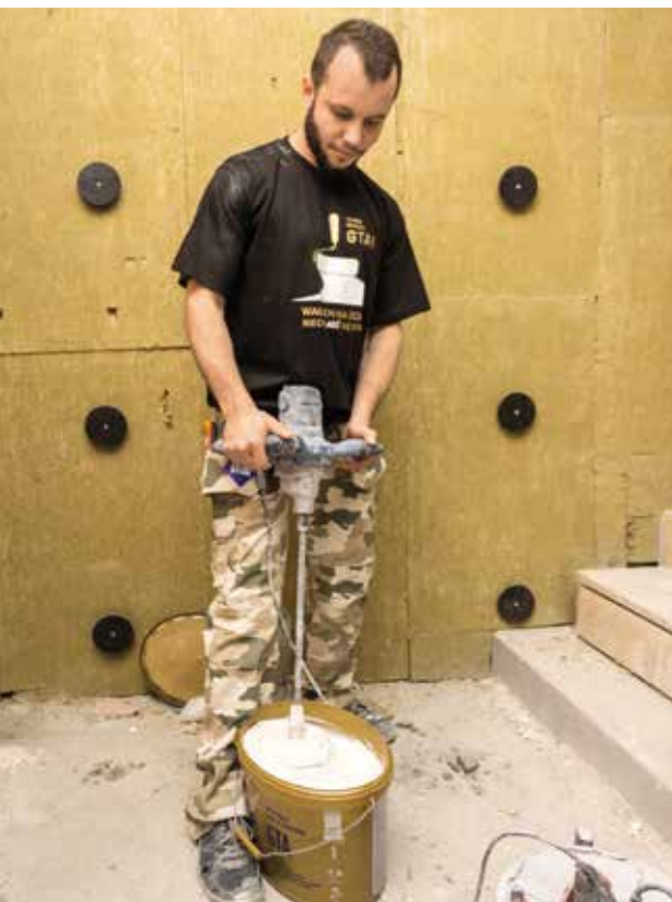
Gładź ATLAS GTA została zastosowana na inwestycjach zarówno jako masa finiszowa, jak i masa „konstrukcyjna”.
