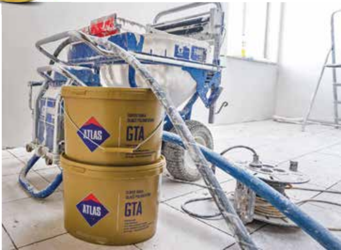
Gładź GTA bardzo dobrze nakładała się agregatem Graco T-Max 506.
