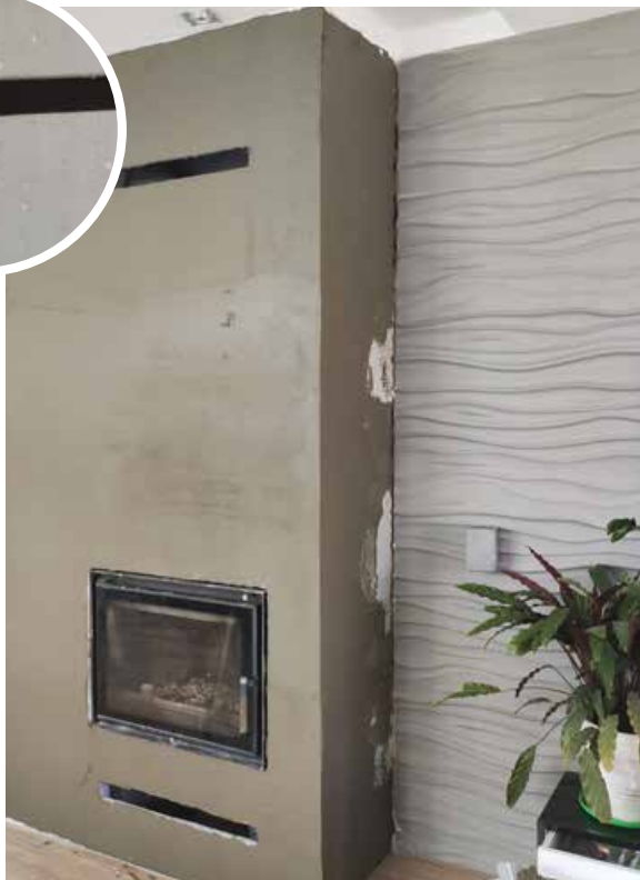
FOT. 8 W trakcie prac: odtworzona obudowa, zaciągnięta siatką, przygotowana do montażu okładziny wielkoformatowej.
