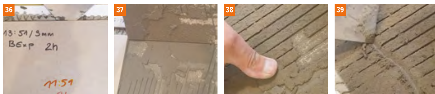
Fot. 36, 37, 38, 39 Klej szybkowiązący nr 2 (klasa „F”). Po uniesieniu płytki wyraźnie widoczne jest zerwanie w warstwie kleju. Klej jest tylko częściowo związany, łatwo rozciera się pod palcem lub narzędziem.
