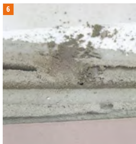
Fot. 4, 5, 6 Geoflex Express. Test twardości zaprawy klejowej wykonany na złączach „zębach” po 1,5 godz.: silny nacisk powoduje skruszenie zaprawy, kolor na prze- kroju jest średnioszary. Powierzchnia okładziny może być obciążana, możliwe jest już też jej spoinowanie.
