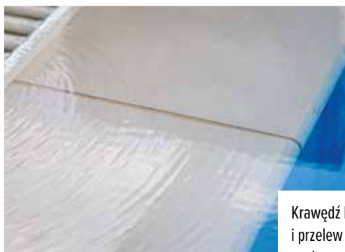
Ściana niecki w strefie falowania wody – na fudze są widoczne algi, które w Deepspot są usuwane ręcznie przy pomocy szczotek z miękkim włosiem lub gąbek.
