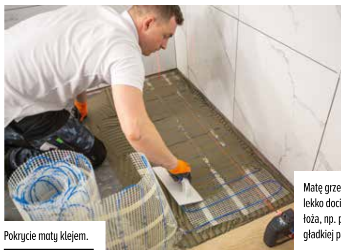
Rozprowadzenie kleju na podłozie.
