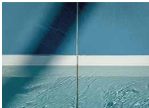
Ściana niecki w strefie falowania wody – na fudze są widoczne algi, które w Deepspot są usuwane ręcznie przy pomocy szczotek z miękkim włosiem lub gąbek.
