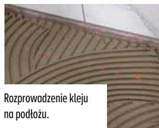
Aplikacja kleju ATLAS Ultra Geoflex na podłozie.
