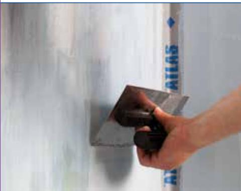
Die Hydroisolierung unter den Fliesen hat die Estriche und den Putz vor Wasserschäden zu schützen. Diese wird in zwei Schichten, mit Pinsel oder einer Stahlkelle aufgetragen. In die erste Schicht werden die Abdichtungselemente eingelassen. Diese bilden den integralen Bestandteil der Hydroisolierbeschichtung und garantieren deren Dichtheit an problematischen Stellen. Wir empfehlen den Einsatz der Flüssigfolie ATLAS WODER E, die sehr einfach in der Anwendung ist.
