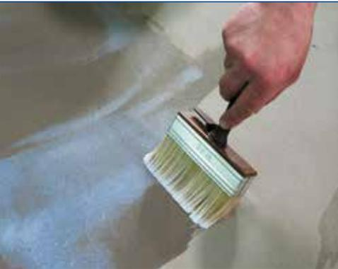
Wände und Fußböden sollen vor dem Fliesenlegen, an Stellen, wo die Hydroisolierung nicht verlegt wurde, grundiert werden. Je nach den Eigenschaften des Untergrundes (saugfähig oder nicht saugfähig, glatt bzw. rau, usw.) sind entsprechende Emulsionen; ATLAS UNI-GRUNT zur Reduktion der Saugfähigkeit bzw. ATLAS GRUNTO-PLAST zur Steigerung der Haftfähigkeit einzusetzen. Zum Auftragen dieser Emulsionen brauchen wir Pinsel oder eine Rolle.
