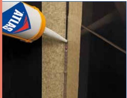
Das Silikon gleichmäßig in die Spalten so einführen, damit eine unwesentliche Menge Restmaterial bleibt. Keine freien Stellen lassen. Während 10–15 Minuten die Oberfläche des Silikons mit einer speziellen Kelle glätten. Die Kelle zuvor in einer Wasserlösung, beispielsweise mit Seife nass machen. Es wird empfohlen, die Fugen so zu gestalten, damit das Wasser frei abfließen kann. Wir empfehlen das Sanitär-Silikon ATLAS ARTIS, das gegen Pilz und Schimmel resistent ist.
