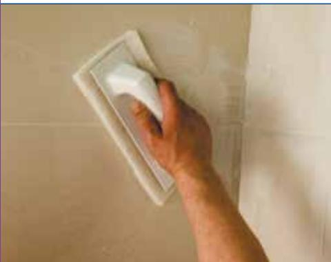
Epoxid-Fugen, beispielsweise Epoxid Fuge ATLAS bestehen aus zwei Komponenten: die Masse (A) und der Härter (B) und werden im Satz geliefert. Diese sollen genau, unter der Einhaltung der Hinweise auf der Verpackung vermischt werden. Die Masse soll sorgfältig und tief in die Spalten, mit einem Gummibrett eingeführt werden. Die Resten der Masse sind von der Oberfläche umgehend (nicht später als nach 20 Minuten) mit einem harten, nassen Schwamm (kaltes Wasser) zu entfernen.
