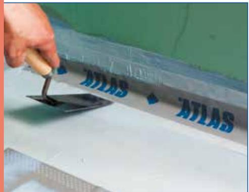
Die Kanten, welche die Wand mit dem Fußboden bzw. mit der benachbarten Wand verbinden, aber auch den eventuellen Dilatationen entlang sind die ABDICHTUNGSBÄNDER ATLAS einzukleben. Hierfür ist diesen Kanten entlang die Hydroisoliermasse so anzubringen, damit man darin die Netze, die sich auf beiden Seiten dieses Bandes befinden einlassen kann. Ähnlich sind die DICHTUNGSECKEN ATLAS, welche die Bänder in den Eckbereichen der Räume ergänzen zu befestigen.
