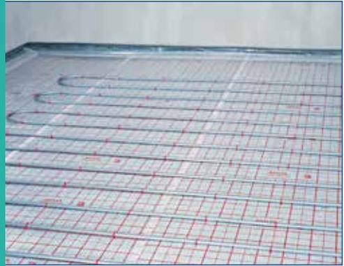
Die Heizungsinstallation prüfen und befestigen. Es wird empfohlen, den Estrich in einer Schicht (bei gesicherter stabiler Befestigung der Heizungsinstallation, beispielsweise mit ATLAS POSTAR 20) herzustellen. Die Höhe des Estrichs über dem Heizelement soll mindestens 35 mm betragen. Die Bodenheizung kann auch aus einer Heizungsmatte bestehen. Diese wird aber in der Endphase von Arbeiten, bereits nach der Ausführung der Hydroisolierung installiert.
