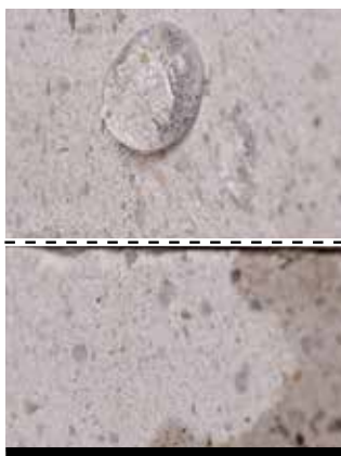
powierzchnie piaskowca, cegły, tynków
