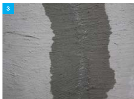
Postupné uzatváranie trhliny kryštalizujúcimi soľami, stále dochádza k miernemu presakovaniu vody. Účinok po 7 dňoch.
