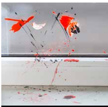
забруднення після фарб, ґрунтів і штукатурок
