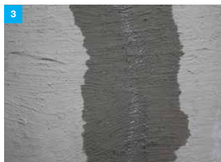
3 Postupné uzavírání trhliny krystalizujícími solemi, stále dochází k mírnému prosakování vody. Účinek po 7 dnech.
