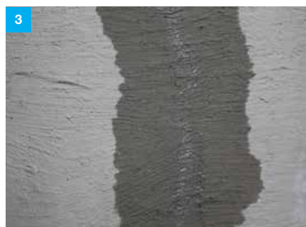
Stopniowe zamykanie rysy przez krystalizujące sole, występuje jeszcze niewielkie sączenie wody. Efekt po 7 dniach.
