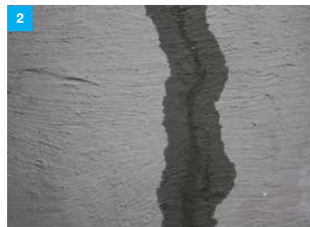
Stopniowe zawilgocenie powłoki izolacyjnej w miejscu pojawienia się rysy.
