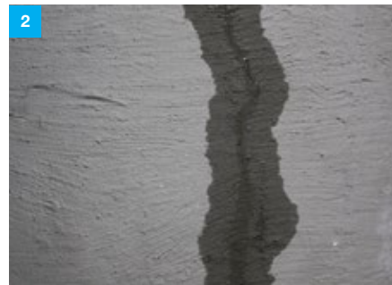
Postupné vlhčenie izolačnej vrstvy na mieste vzniku trhliny.
