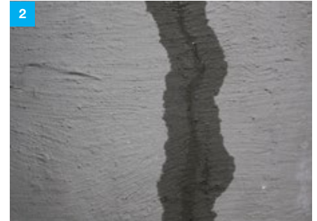
Allmähliche Befeuchtung der Abdichtungsschicht im Bereich des Risses.
