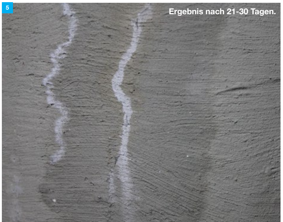
Allmähliches Schließen des Risses durch kristallisierende Salze, es bleibt nur noch etwas Sickerwasser. Ergebnis nach 7 Tagen.
