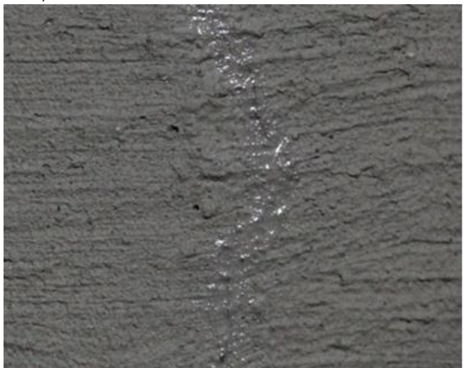
Fot. 2. Postupné zvlhčovanie izolačného náteru v mieste vzniku trhliny
