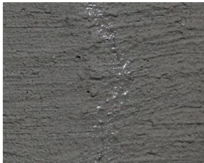
Fot. 3. Stopniowe zamykanie rysy przez krystalizujące sole, występuje jeszcze niewielkie sączenie wody. Efekt po 7 dniach.
