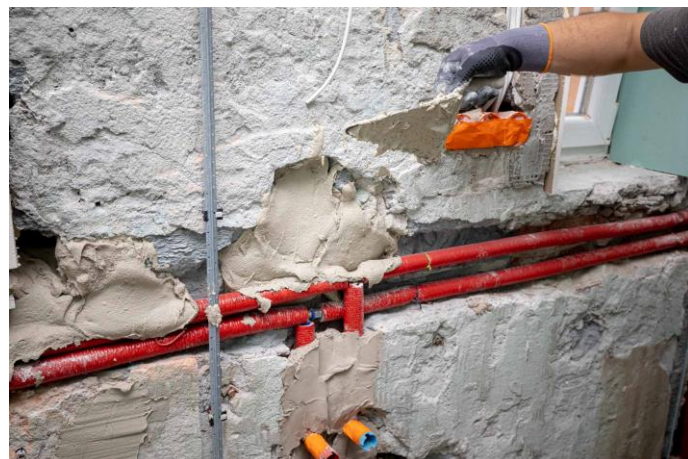
Vyplnenie instalačných drážok.
