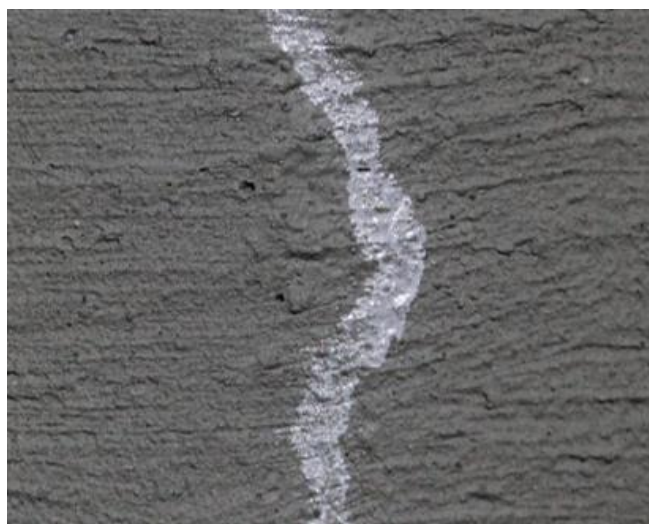
5 nuotr. Pamažu daugėja druskos kristalų ant įtrūkio paviršiaus, papildomai užsandarinama. Rezultatas po 35 dienų.
