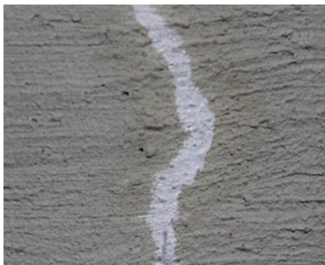
4 nuotr. Druskos kristalai užpildo įtrūkį, vanduo neteka. Rezultatas po 21 dienos.
